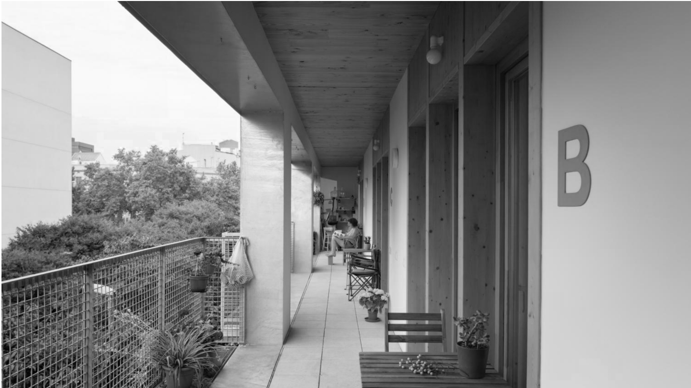
Fig. 45: Fotografía galería común. Edificio La Balma, Lacol. Extraído de lacol.coop
