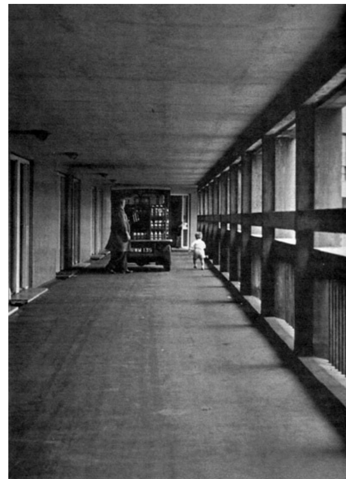
Fig. 16: Calles en el aire de Park Hill por las que pasaba un "milk float" repartiendo leche a los vecinos. Extraído de https://municipaldreams.wordpress.com/2013/04/16/the-park-hill-estate-sheffield-streets-in-the-sky/
