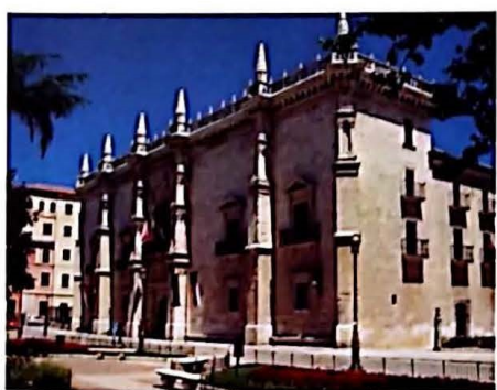
▲ Fig. 8. Fachada principal del Colegio Mayor de Santa Cruz en la actualidad.
