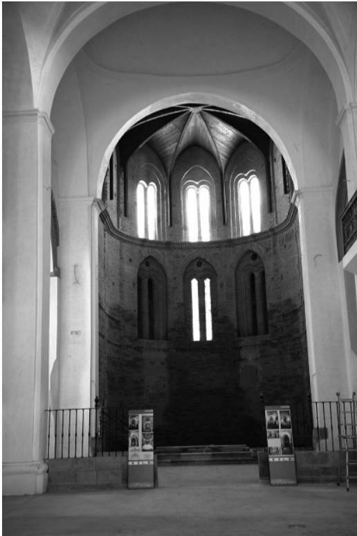
Figura 13 Ventanas inferiores y superiores con reinterpretación de bóveda de crucería, tras intervención. 2011. (Archivo propio)
