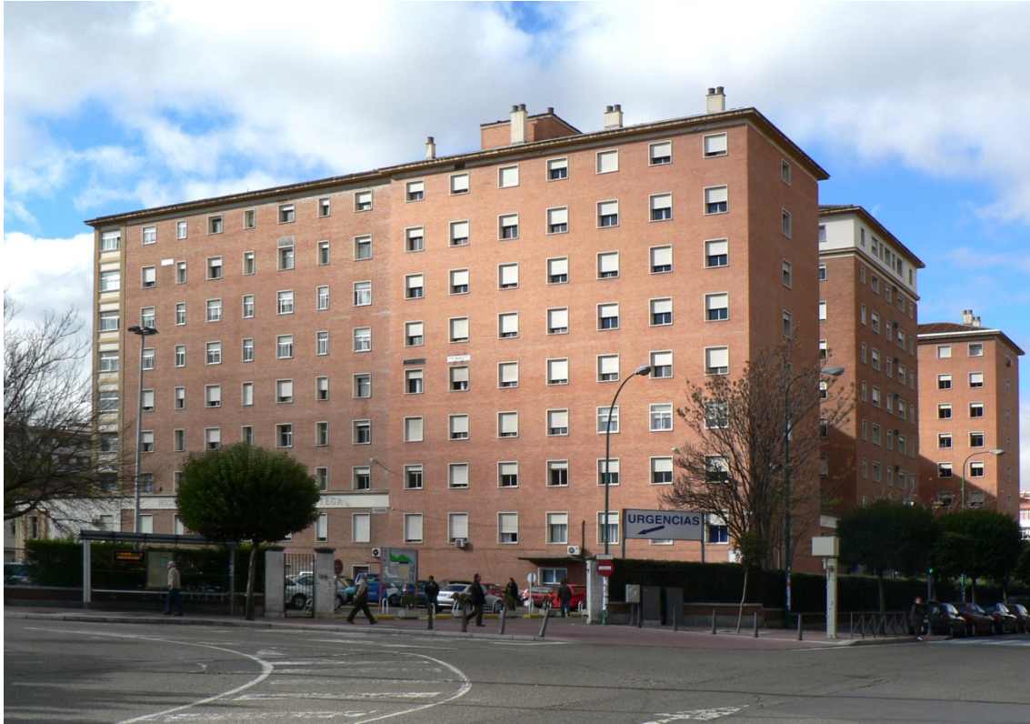
FOTOGRAFÍA A.5. Vista exterior del acceso rodado a urgencias del antiguo HURH.
