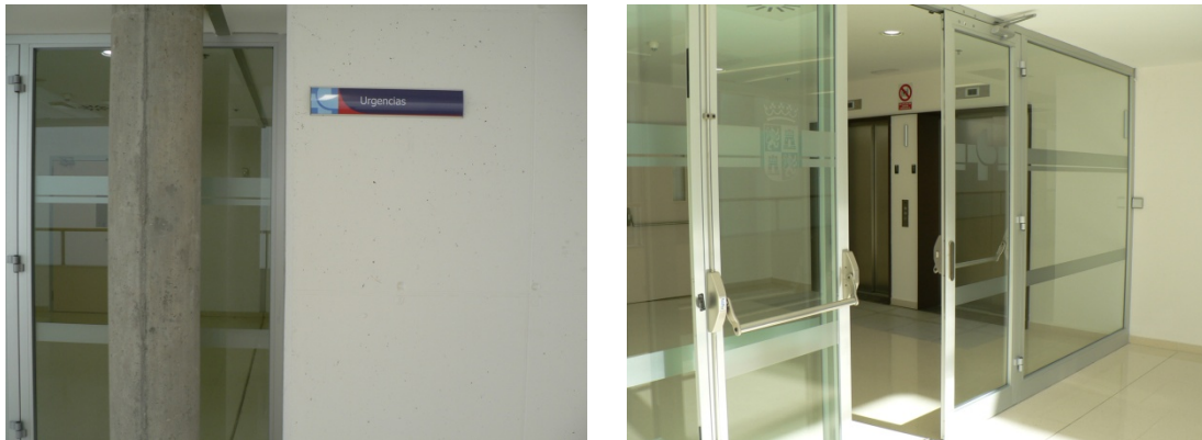
FOTOGRAFÍA B.41. Acceso a urgencias por el interior del nuevo HURH.
