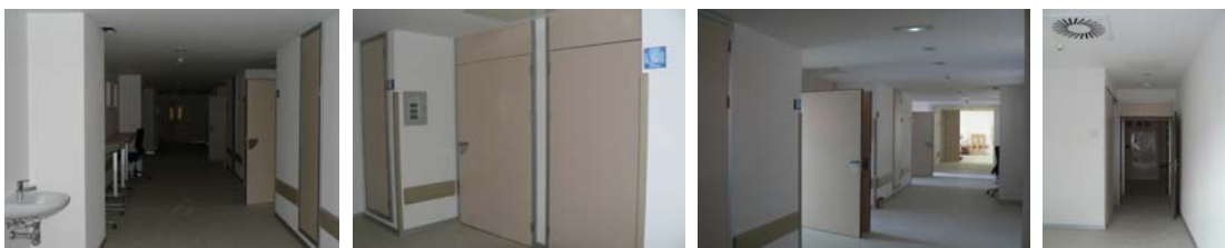
FOTOGRAFÍA B.30. Comunicación de las habitaciones de TAMO del nuevo HURH.
