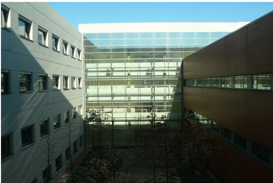
FOTOGRAFÍA B.8. Vista de los patios interiores del nuevo HURH.
