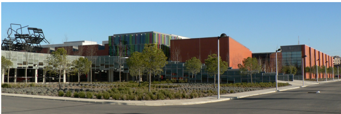
FOTOGRAFÍA B.5. Vista panorámica de las fachadas delantera y lateral del nuevo HURH.
