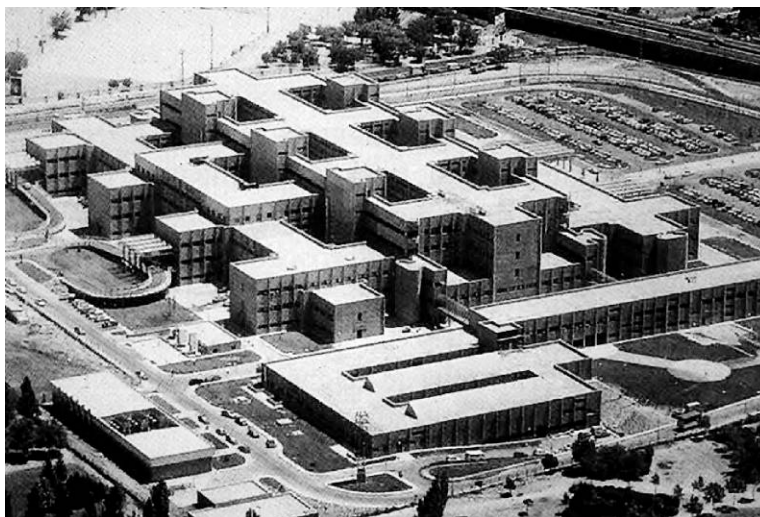
FIGURA III.18. Hospital Universitario de Getafe en Madrid (España). Vista aérea.
