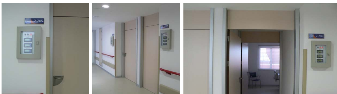
FOTOGRAFÍA B.33. Vistas desde el pasillo de las habitaciones de TOH del nuevo HURH.
