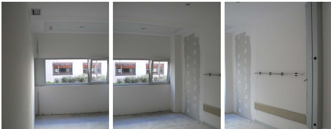
FOTOGRAFÍA B.28. Secuencia panorámica interior de TAMO del nuevo HURH.
