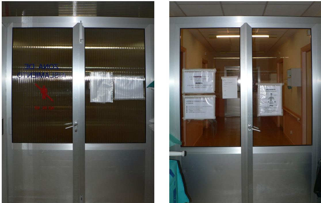
FOTOGRAFÍA A.15. Puertas de la zona previa de acceso a las habitaciones TAMO del antiguo HURH.
