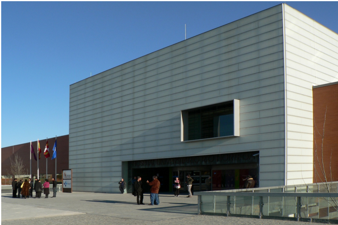
FOTOGRAFÍA B.3. Vista de acceso principal peatonal del nuevo HURH.
