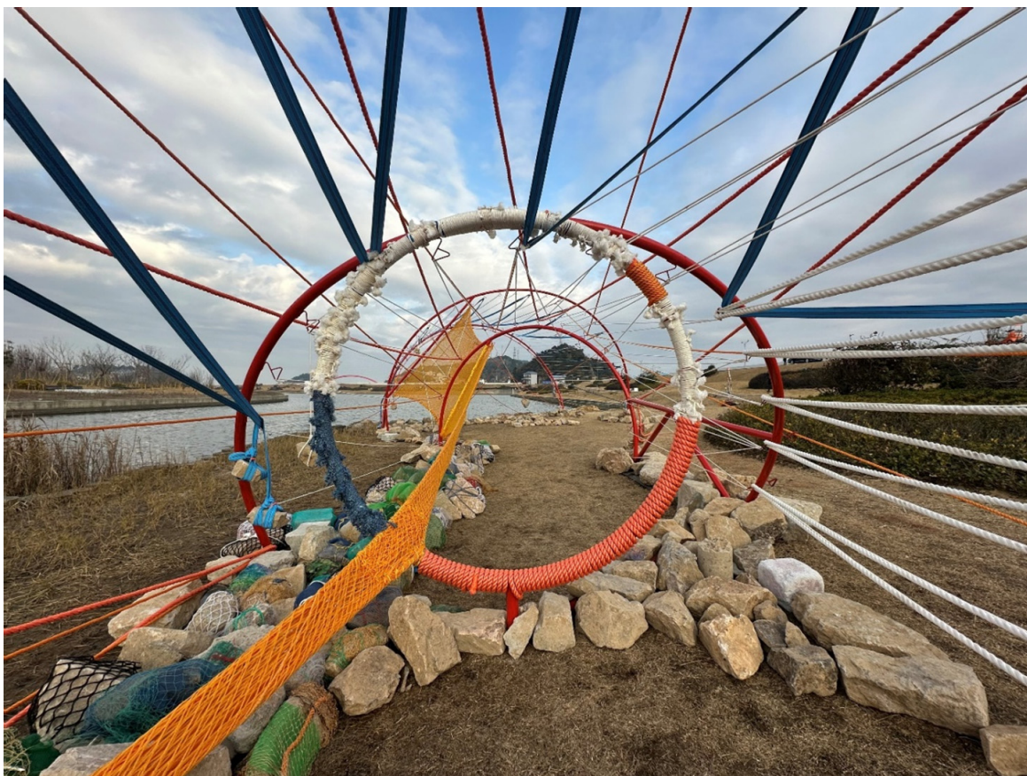
Figura 8. Redes de pesca y maromas conectando los arcos estructurales. Wenzhou-Kean University.
