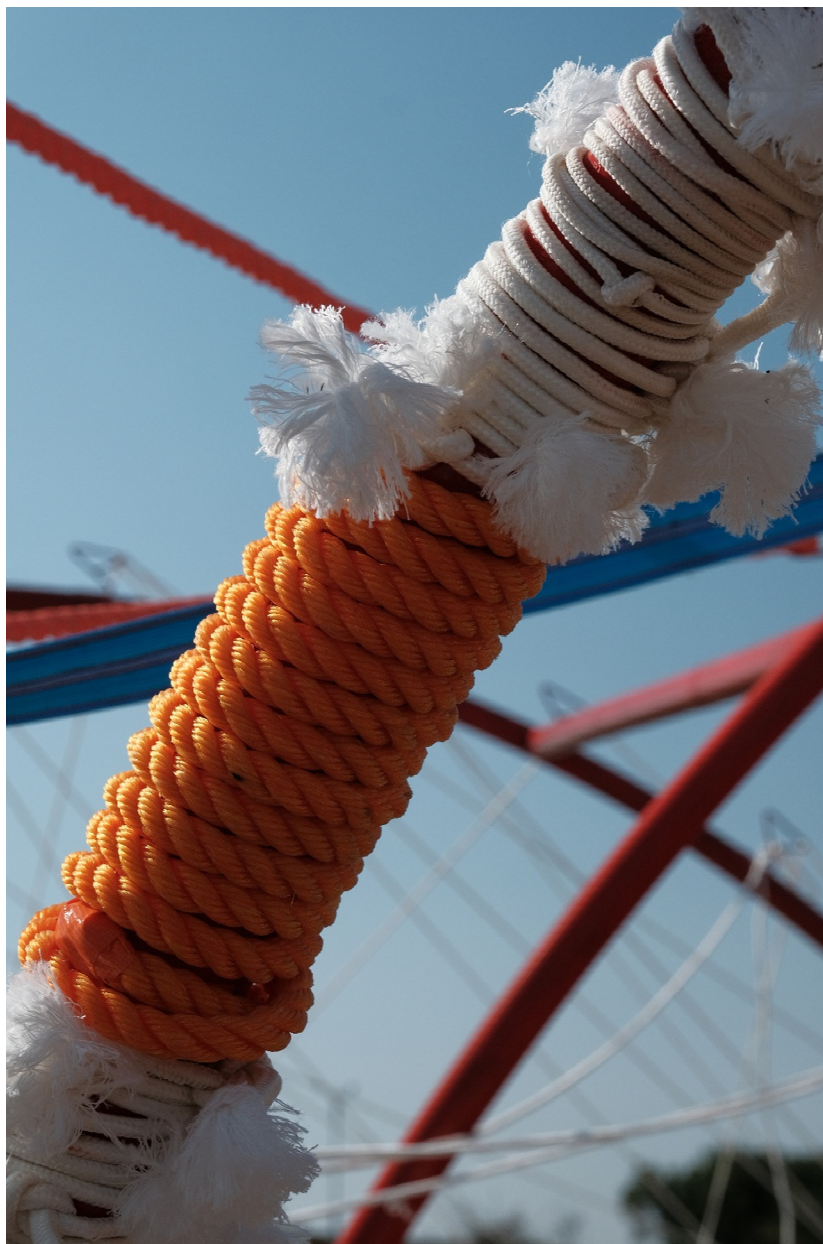
Figura 3. Detalle de las maromas que conectan los arcos estructurales.
