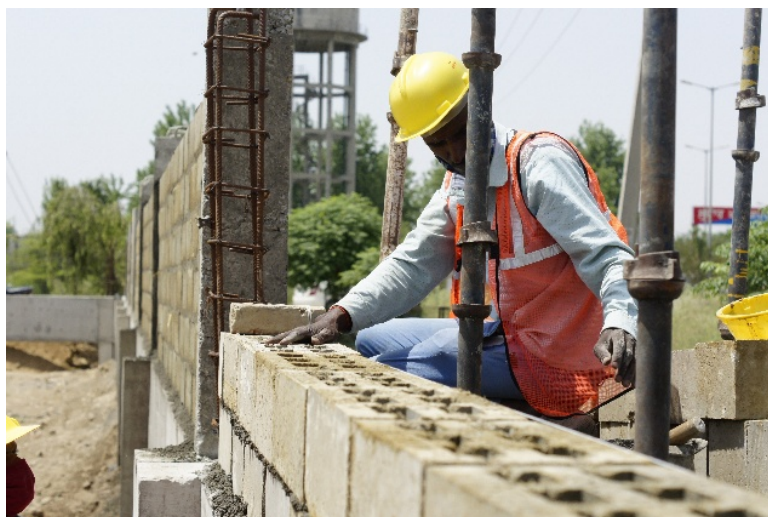
Figura 3. Construcción de muro perimetral con bloques Agrocete. GreenJams.
