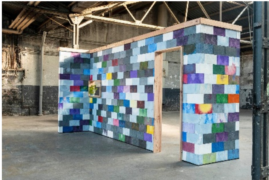
Figura 1. Pared formada por bloques de residuos plásticos. Precious Plastic.
