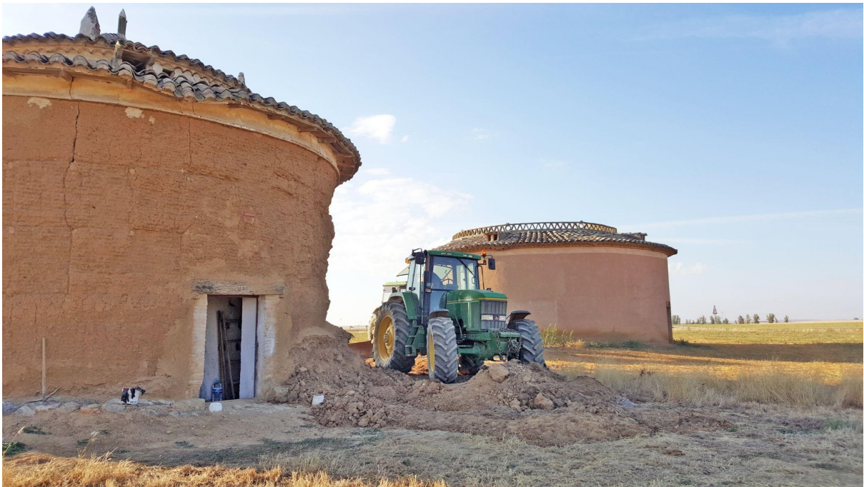
Figura 2. Fotografía de un tractor levantando la tierra desprendida del palomar para su reutilización en Villafrades de Campos, dentro del taller “Tres palomares, tres revocos” realizado en 2021. Fuente: Giovanni Olcese.
