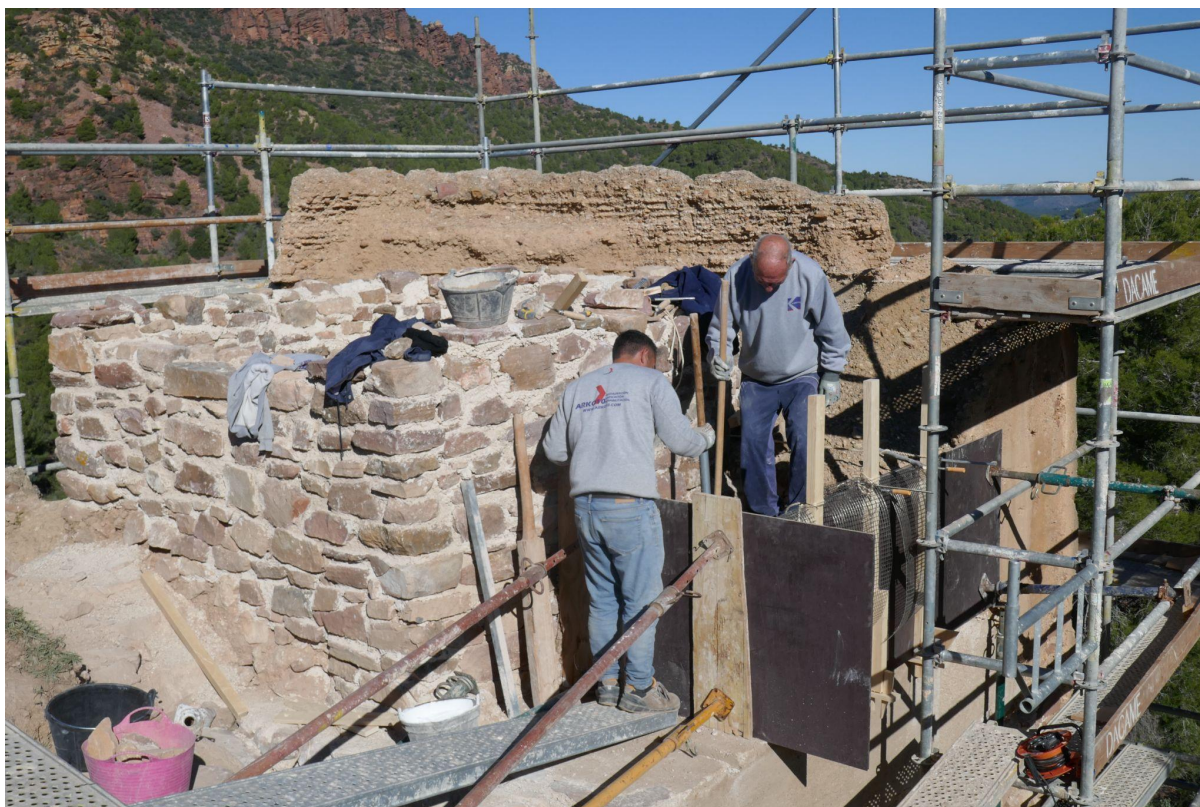
Figura 1. Imágenes de obra en Segart, envolviendo la torre con tapia de tierra. Fuente: cedidas por Fermín Font
