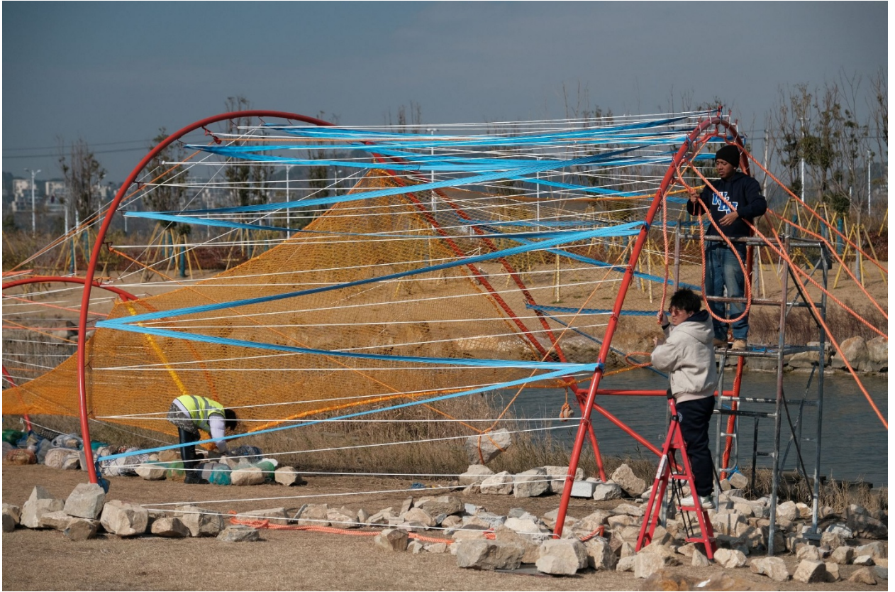
Figura 7. Proceso de atado de las maromas a los arcos estructurales. Wenzhou-Kean University.
