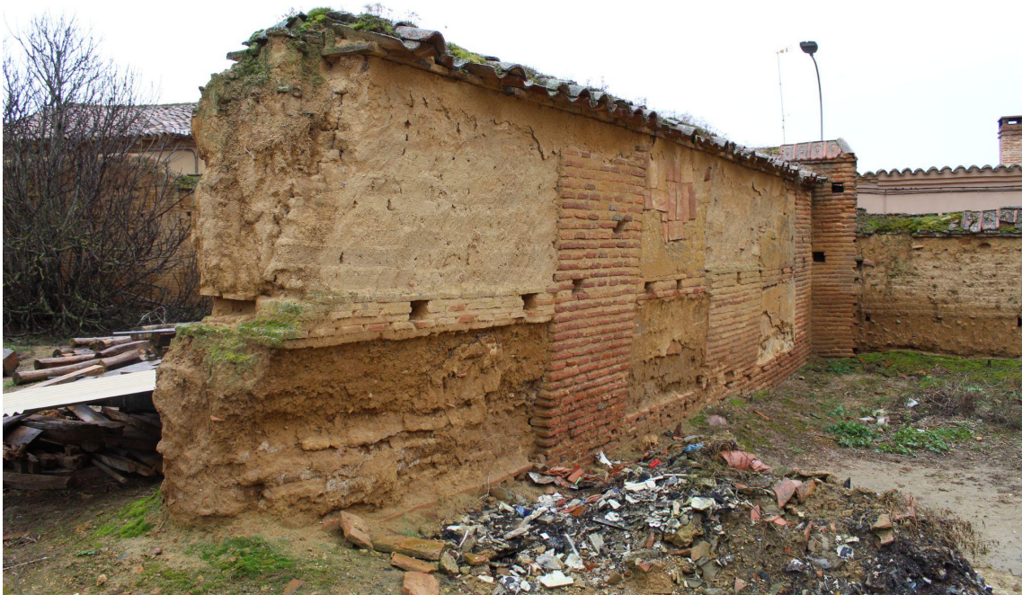
Figura 3. Fotografía del estado previo de la tapia encadenada del patio del palacio de Grajal de Campos en el ámbito del taller realizado en 2021. Fuente: Giovanni Olcese.
