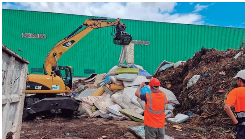
Fig.3.Centro de tratamiento de residuos Alicante
