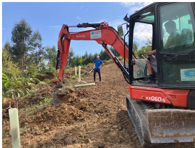
Figura 45. Imagen de la excavadora trabajando.
