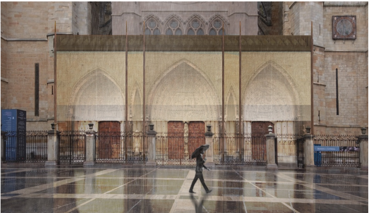
Fotomontajes con el sistema de doble membrana inteligente en dos situaciones ambientales
