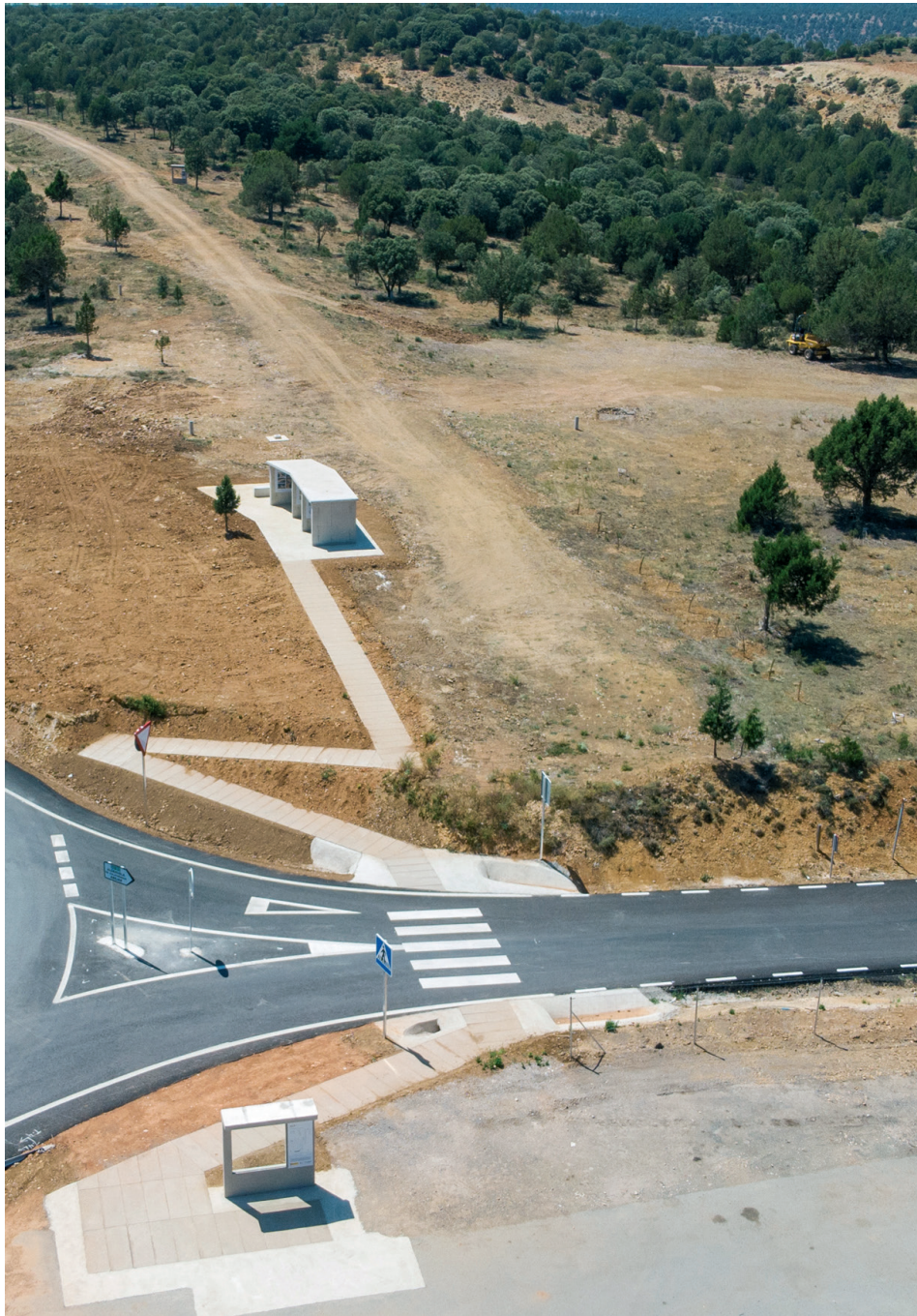
Fig. 12. Fotografía aérea de Venta Nueva. Fuente: Isaac Moreno Gallo.
