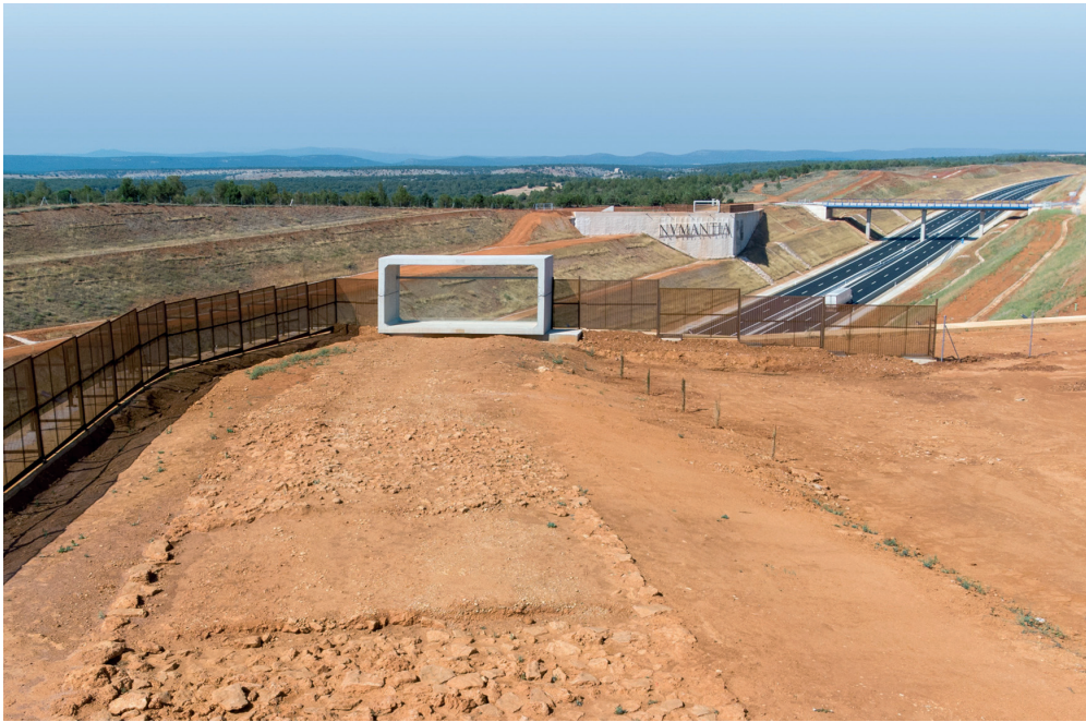
Fig. 23. Ventana-mirador sur. Fuente: Isaac Moreno Gallo.
