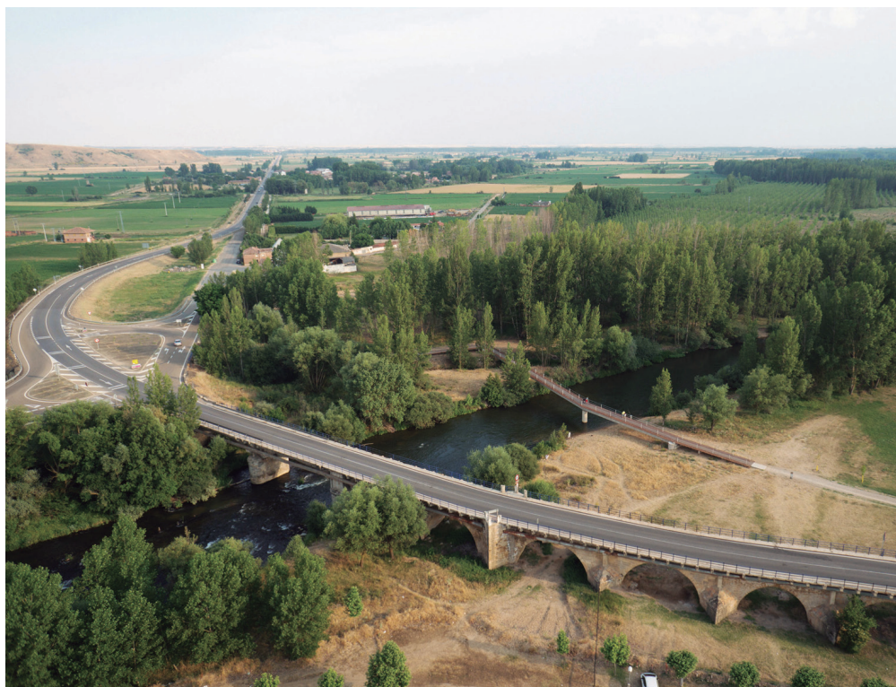
Fig. 1. Pasarela peatonal para peregrinos del Camino de Santiago sobre el río Esla en Puente Villarente, León. Fuente: LAB/PAP.
