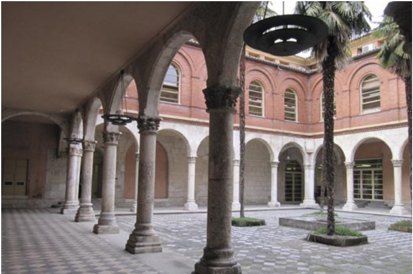
Patio del palacio de los condes-duques de Benavente (Valladolid). Foto: Javier Pérez Gil.
