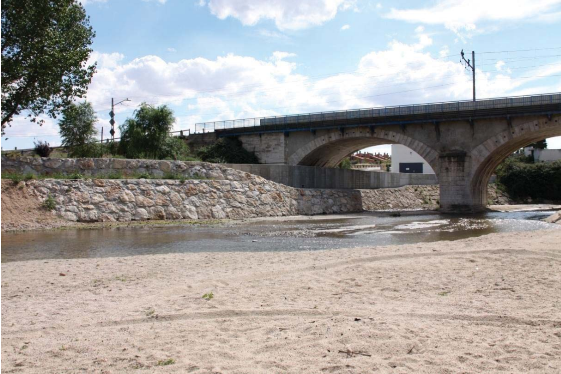
Figura 56. Muro de contención de avenidas
