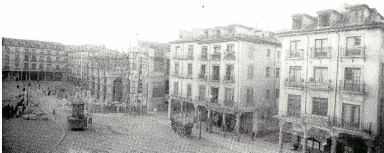
Construcción del Nuevo edificio del Ayuntamiento. Año 1907.
