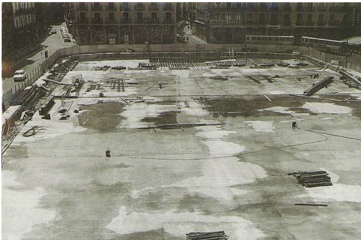
Inicio de la construcción del aparcamiento subterráneo en la Plaza Mayor. Año 1970.
