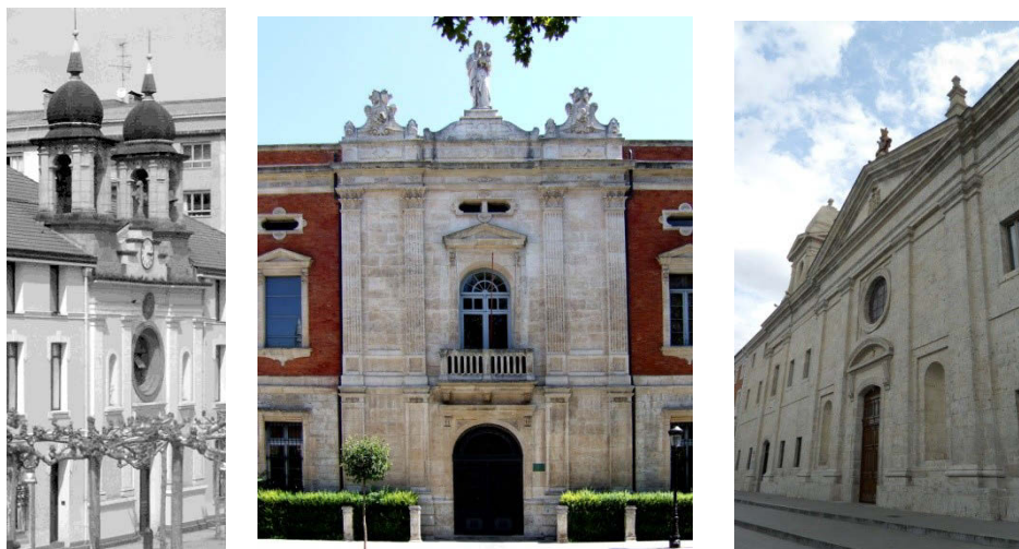
Figs. 2, 3 y 4. Estado actual de las fachadas principales de los colegios de San José en Tolosa (izquierda), y de San José (centro) y de Agustinos Filipinos en Valladolid (derecha).
