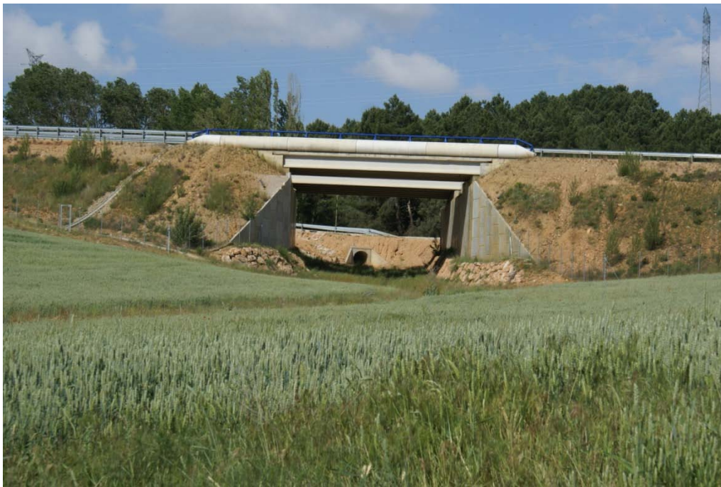
Figura 5: Detalle de paso inferior en la A-15 a la altura del punto 01NA-N-111A-LOS RÁBANOS.
