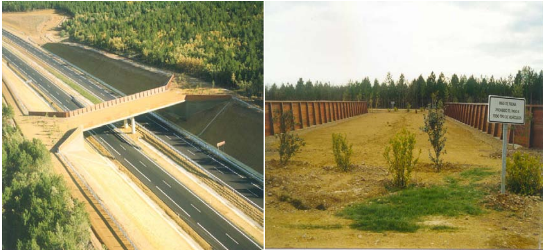
Figura 31.- Paso superior en la autovía León-Burgos. Fotos Junta de Castilla y León y Carme Rosell.
