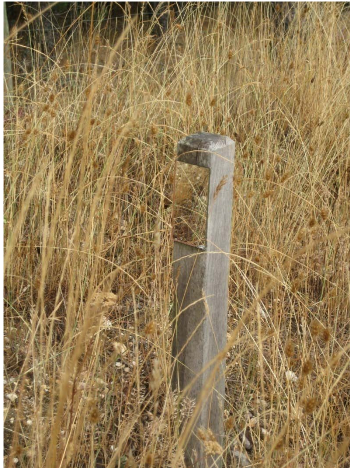
Figura 91.- Detalle de falta de mantenimiento en estaca con espejo reflectante (Fotografía B. Asenjo).
