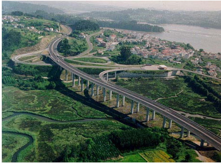
Figura 34.- Viaducto en la autovía del Atlántico, A9. (Foto AUDASA)
