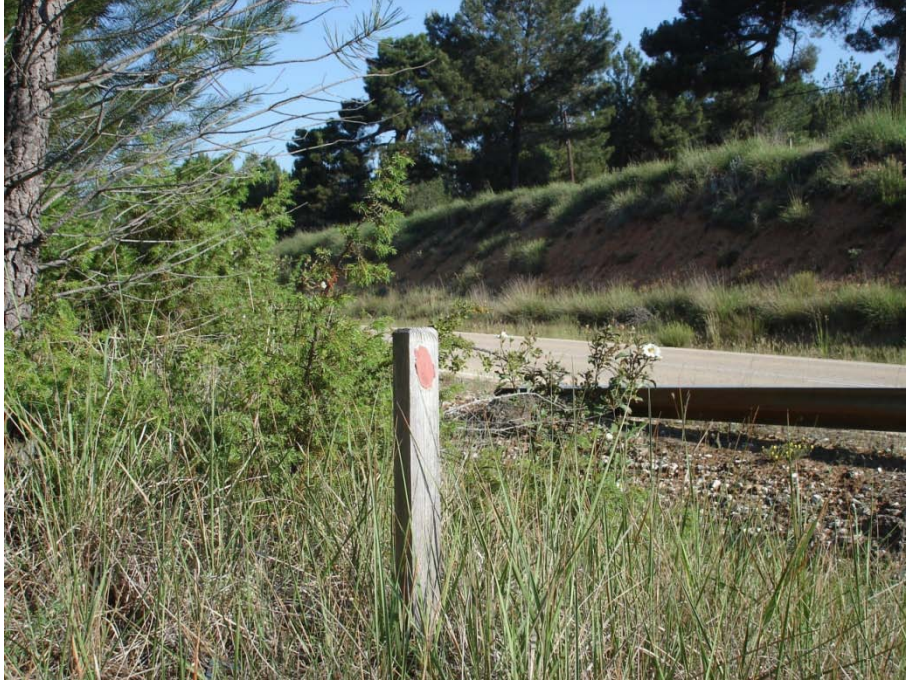
Figura 4: Detalle medida correctora (espejo reflectante) sin mantenimiento en el punto11NP- SO-110- MATAMALA DE ALMAZÁN.
