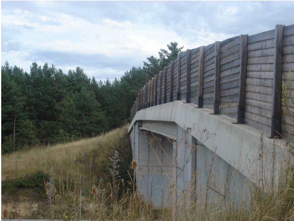
Figura 33.- Detalle de pantallas opacas en un paso de fauna (carretera CL-117) (Foto A. Mercado).
