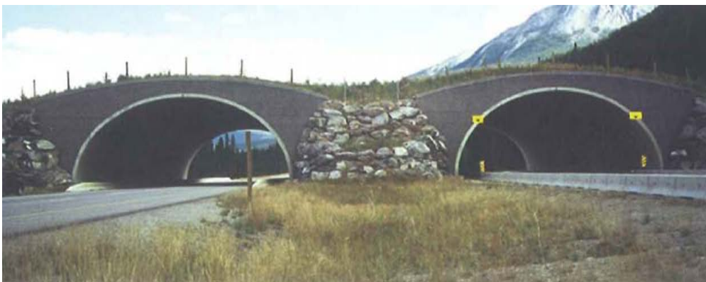
Figura 30.- Paso superior de fauna en el parque nacional de Banff en la autopista Transcanadiense se construyó sobre una carretera ya en servicio. (Foto de H. Bekker)
