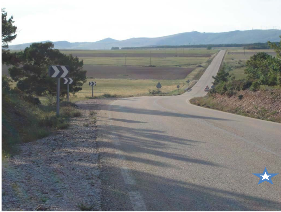
Figura 2: Detalle de localización del punto14NP-SO-P-2102-BOROBIA.
