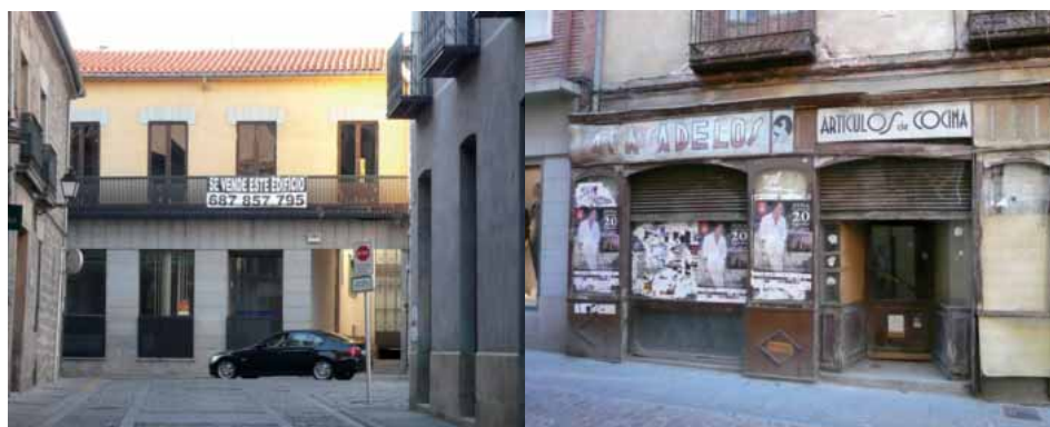
Figura 7.5 Edificios en venta y abandonados en el centro histórico de Ávila, 2011
