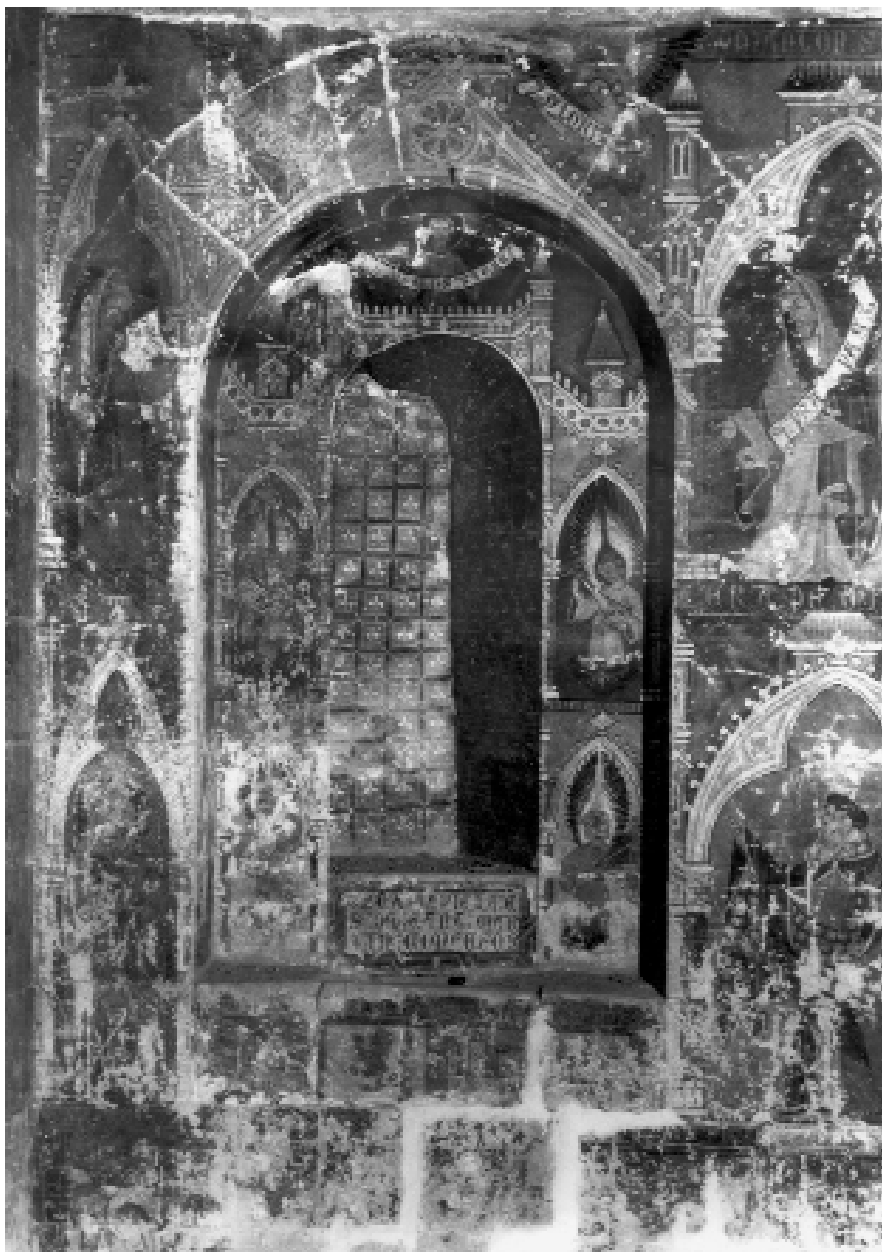
Fig. 2. Salamanca, catedral vieja; pinturas murales del muro oriental de la capilla de San Martín (Antón Sánchez de Segovia, 1262). Estado en 1927 (foto: Institut Amatller d' Art Hispànic).
