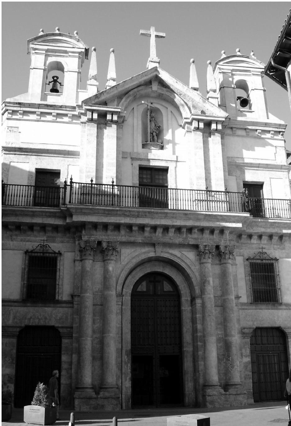
Fig. 1. Valladolid. Iglesia de la Vera Cruz. Fachada
