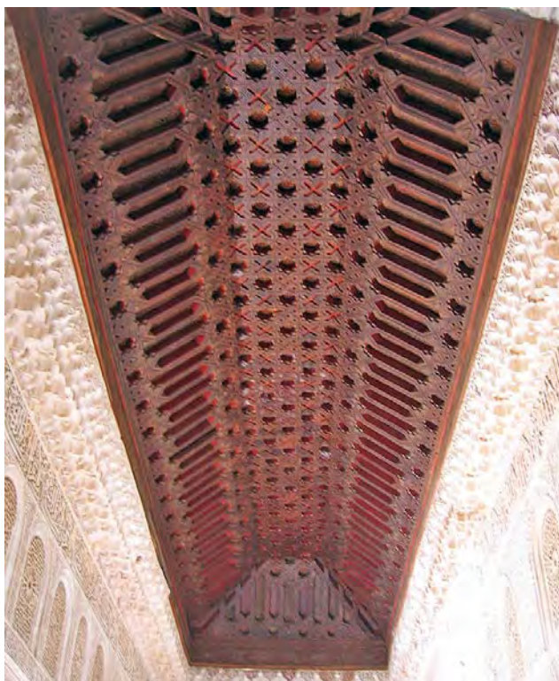
Fig. 5. Armadura del pabellón norte del Patio de la Acequia. Ca. 1273-1302. Generalife. Granada.(Fotografía: J. García Nistal)
