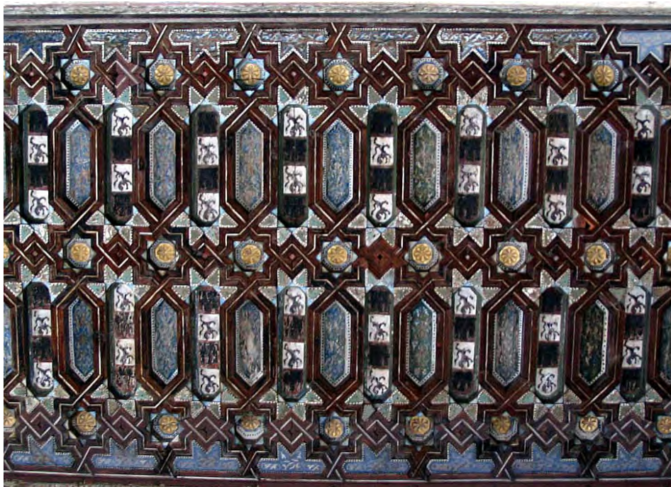
Fig. 4. Detalle de uno de los forjados del Patio de las Doncellas. Ca. 1364-1369. Reales Alcázares de Pedro I. Sevilla. (Fotografía: J. García Nistal)
