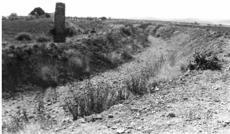
Figura 2: Vista de la Presa romana de Consuegra desde el estribo izquierdo.
