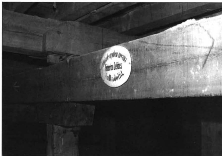
Valladolid. Teatro Calderón. Sistema de sostenimiento del patio de butacas. Carpintería mecánica. Federico Delibes.
