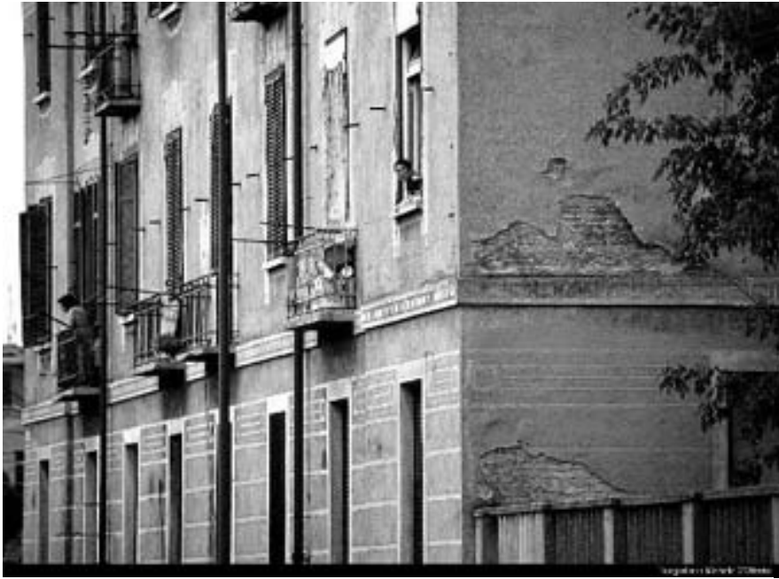
Via Arquata: il grave degrado edilizio del quartiere nel 1995, dopo trent'anni di abbandono.
