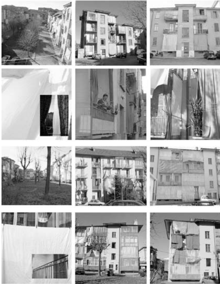
Via Ghedini: addizioni e modifiche delle facciate da parte degli abitanti.
