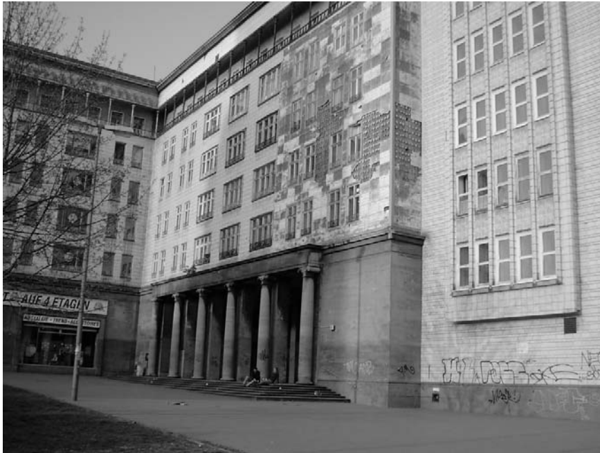
Berlín. Stalinallee. Algunas partes de esta intervención, todavía no rehabilitada muestran el mal estado de conservación que tenían algunas de las más emblemáticas construcciones de la antigua RDA.
