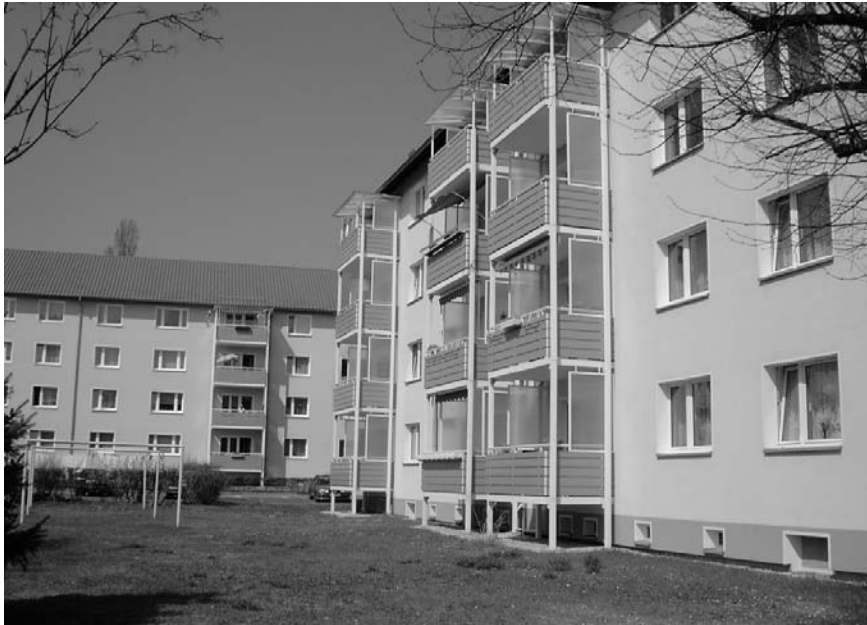
Figura 7. Jena. La mejora de las viviendas que comporta, además de la mejora de la fachada, la incorporación de balcones.
