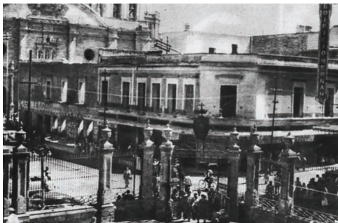
Fig. 1 Manzana que fue demolida frente a Catedral.
