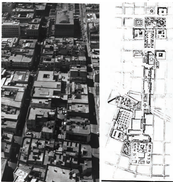
Fig. 11: Las edificaciones demolidas a la izquierda y el eje de La Plaza Tapatía con la Cruz de plazas y los monumentos principales preservados. Fuente: archivo privado.
