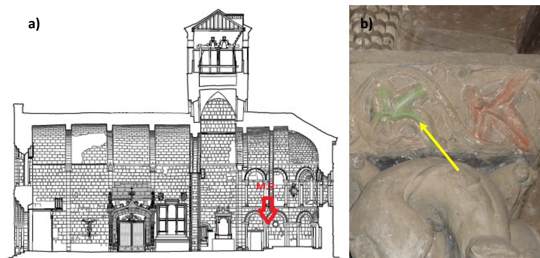
Figura 5.8.- a) Localización del capitel en el interior de la Iglesia. b) Coloración verdosa del capitel.
