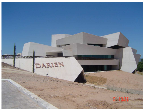
Foto 2. Nuevo edificio de bodegas Darien – Logroño (La Rioja).
