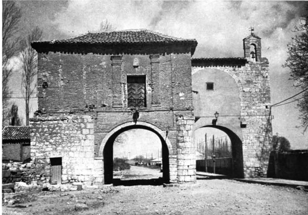
Medina de Rioseco (Valladolid). Puerta de San Sebastián: 1. Fachada principal.—2. Fachada posterior.
