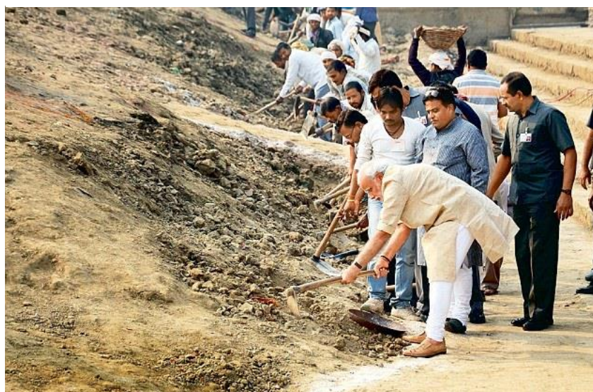
13. El primer ministro de la India, Narendra Modi, trabajando como uno más en las obras de mejora de los ghats.
