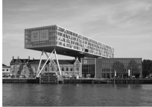
Fig 71. Ejemplo de Celosía Warren con montantes
