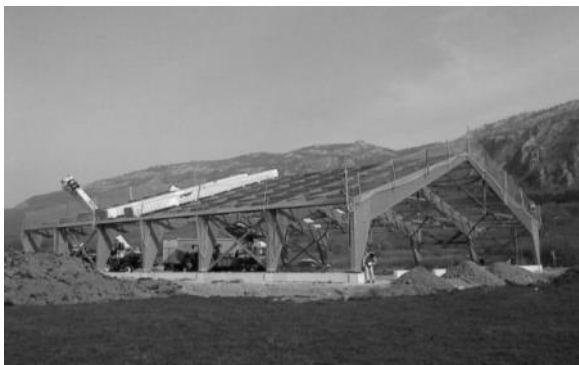
Fig 36. Pórtico de madera microlaminada
