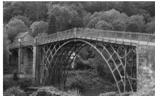
Fig 18. Coalbrookdale _ Ironbridge, Reino Unido
