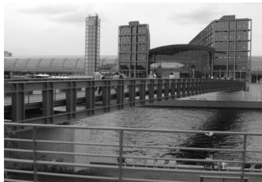
Fig 74. Ejemplo de Celosía Vierendeel
