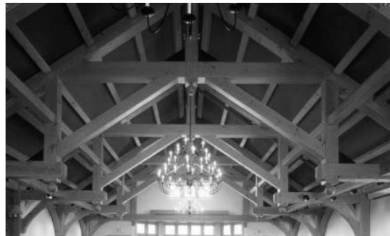
Fig 62. Ejemplo de Hammer Beam
