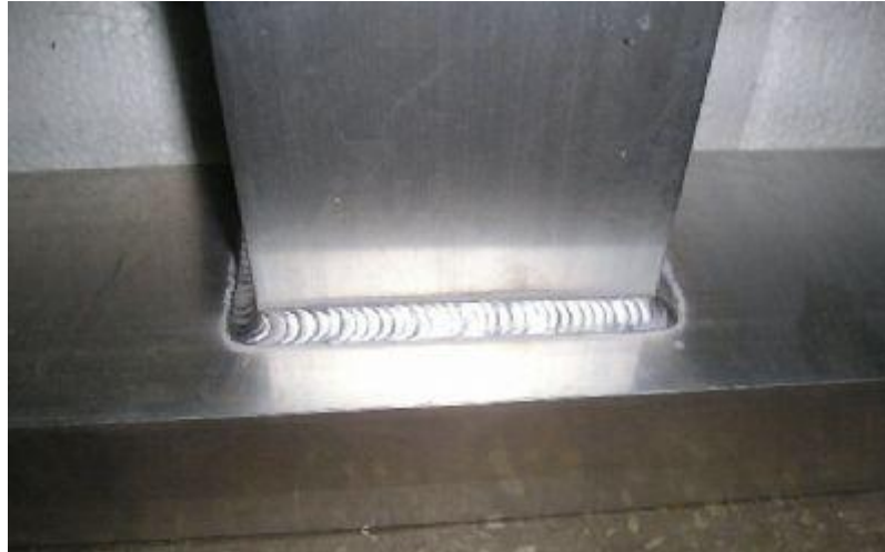
[Figura 85. Cordón de soldadura]
