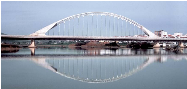
Puente sobre el Guadiana Mérida Santiago Calatrava
