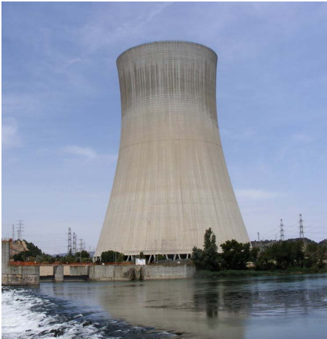
Central térmica en Ascó, Tarragona
