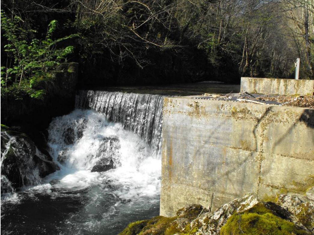
Imagen nº24: vista del azud con el captadero a la derecha
