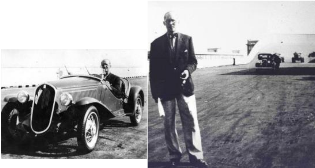
8-23 Le Corbusier en su visita la fabrica FIAT Lingotto, sobre la cubierta de pruebas (1923)
