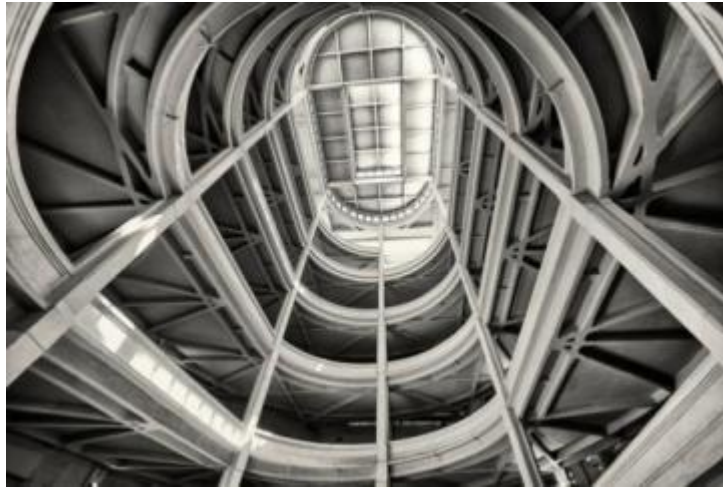
8-42 Mattè Trucco 1928 Rampa helicoidal de la Fiat-Lingotto
