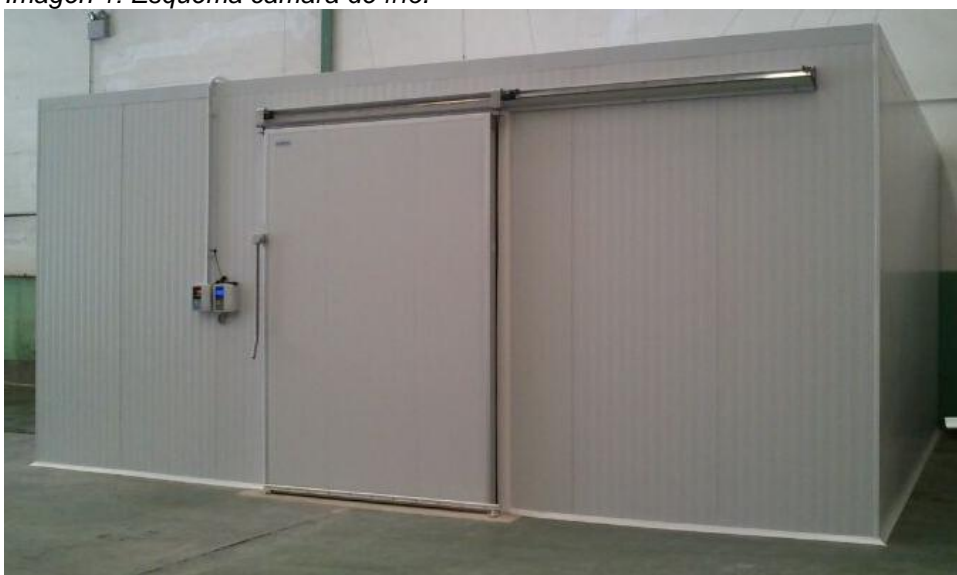
Imagen 2: Ejemplo de cámara frigorífica real.
