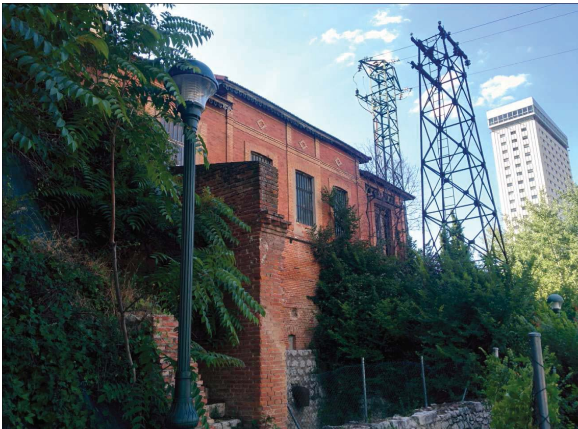
FIGURA 29. Restos de la central. Fotografía del autor 24-06-2015.
