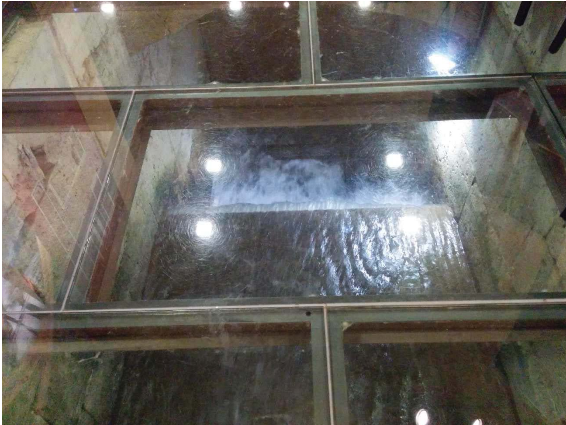
FIGURA 21. Tercer salto del derrame. Fotografía del autor 21-05-2015.
