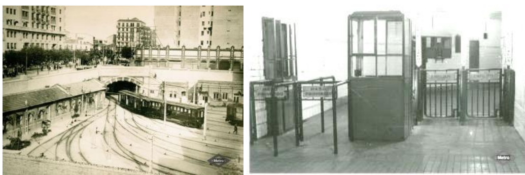
Figura 2.1. Imágenes de la supra e infraestructura del Metropolitano madrileño, años 20.
