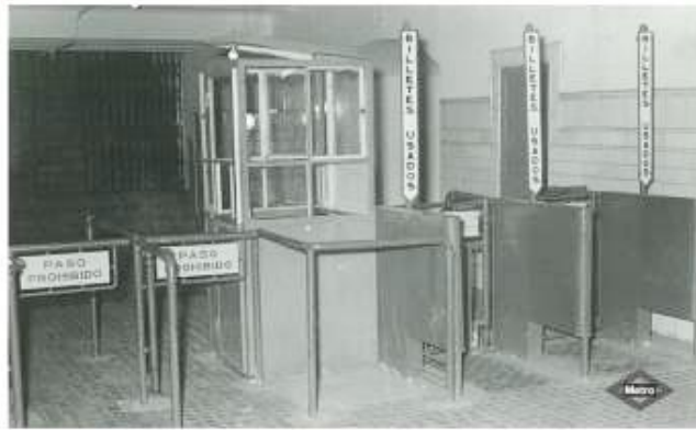
Figura 4.2. Instalación preparada para la colocación de expendedoras de billetes. Fuente: Archivo Metro de Madrid.
