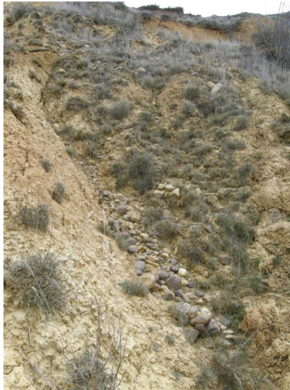
Figura 2.5. Erosión por deslizamientos en la zona de estudio.
