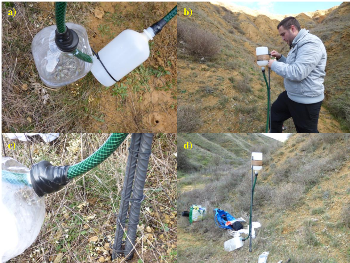
Figura 6.14. Instalación del pluviómetro. a) Enganche del captador de agua, manguera y depósito de recogida de agua. b) Amarre del captador a la varilla de sujeción. c) Deposito apoyado en el suelo. d) Pluviómetro finalizado.
