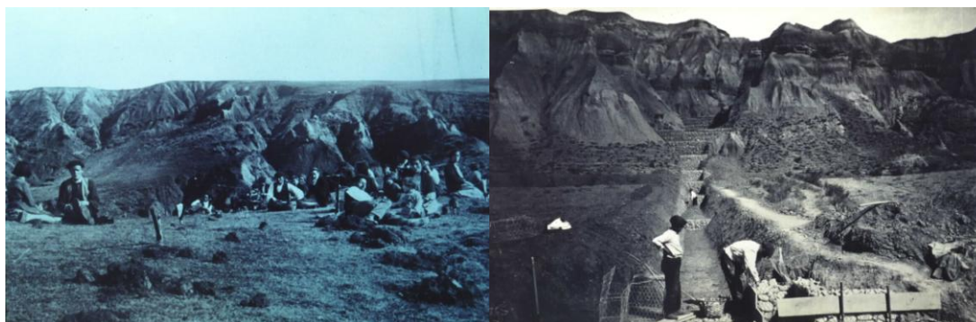
Figura 3.6. Trabajos de restauración en 1932. Fuente: Confederación Hidrográfica del Duero.
