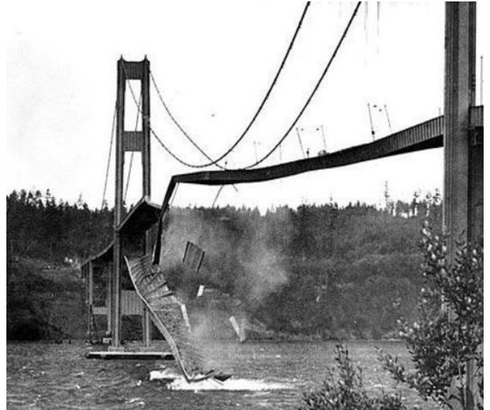
Figura 7: Puente Tacoma Narrows en resonancia
