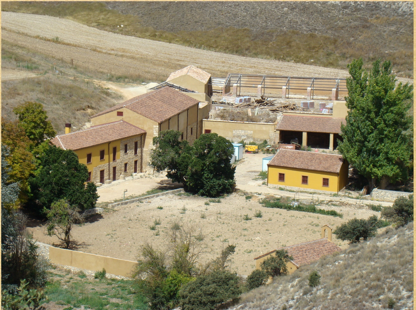
Obras de rehabilitación y nuevas construcciones en el Valle de San Juan. 2011. Foto: E. Delgado
