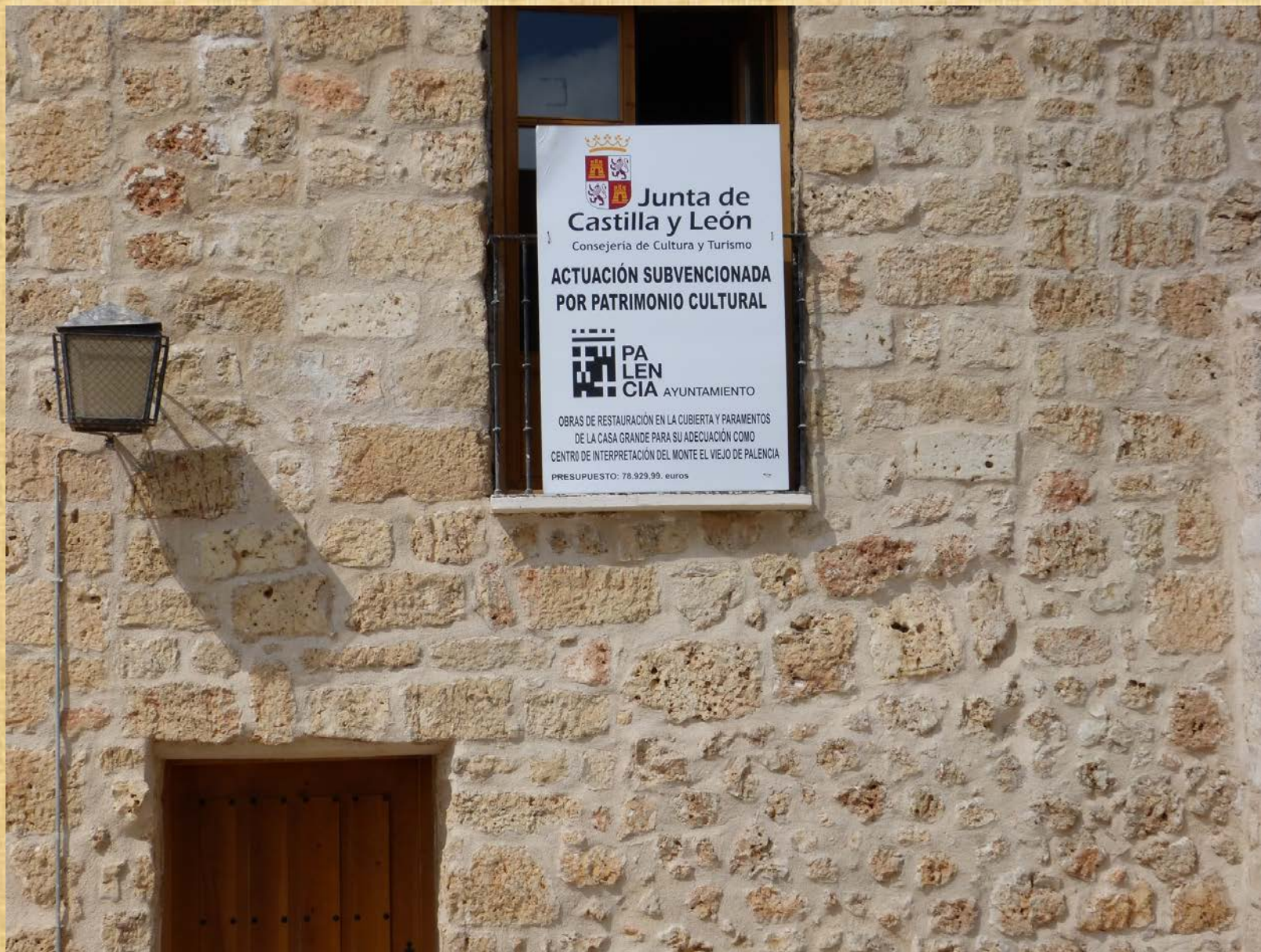
Obras de restauración de la Casa Grande para Centro de Interpretación del Monte. 2021. Foto: E. Delgado
