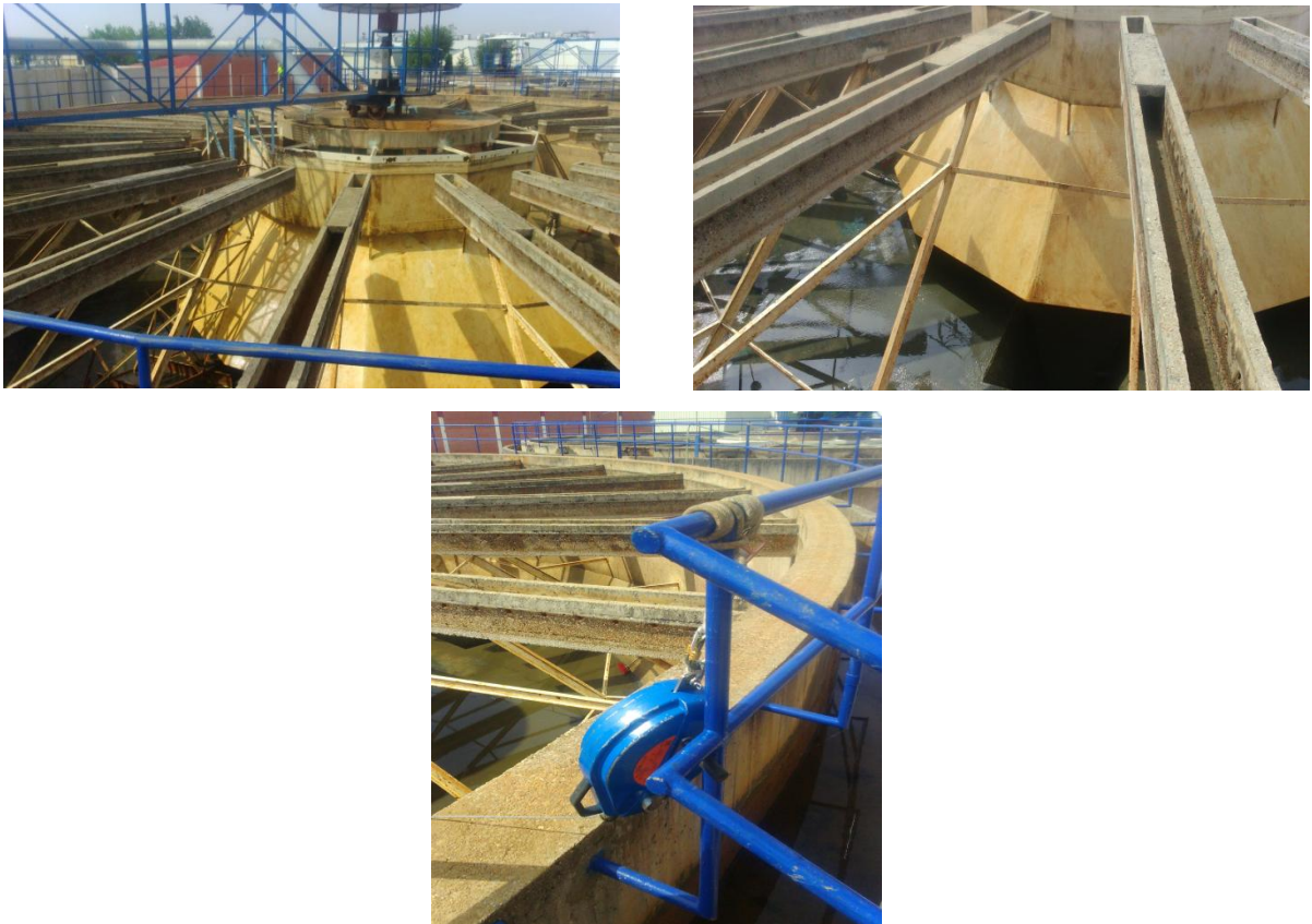
Figura 23. Detalles de la limpieza de un decantador en la ETAP San Isidro
