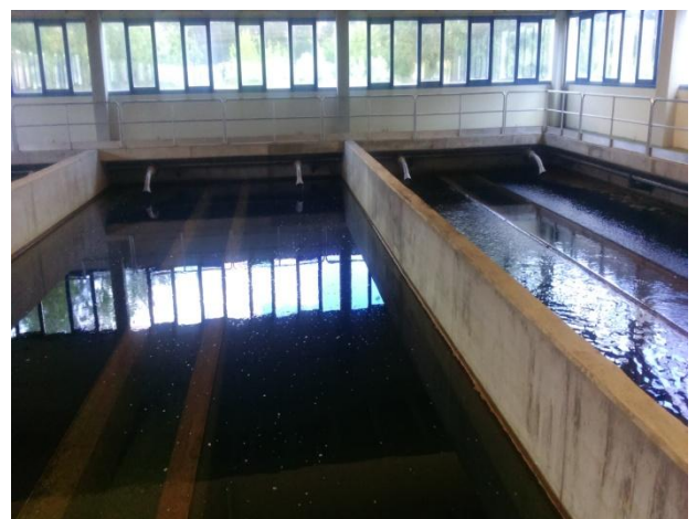
Filtros: de Arena y de Carbón activado
