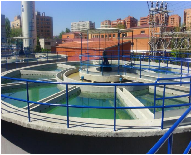
Decantador Acelator y detalle de éste
