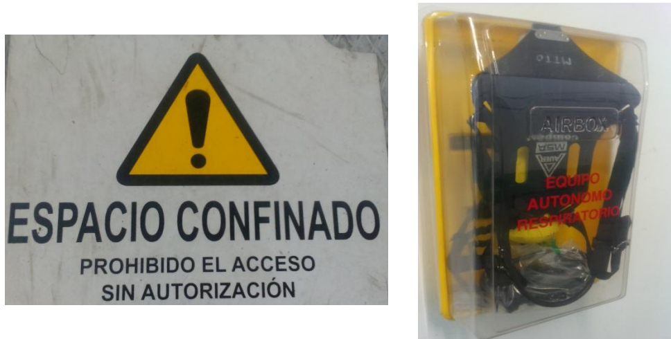
Figura 19. Señalización de Espacio Confinado y Equipo de Respiración Autónoma
