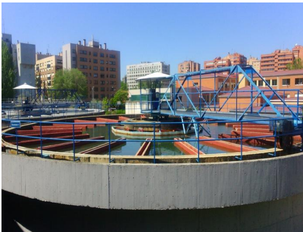
Decantadores: Acelator con carro y Lamelar
