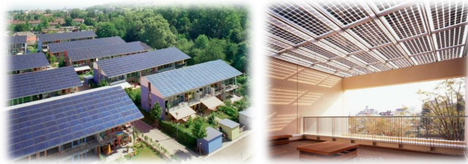
Figura 14. Sistemas BIPV integrados en los tejados inclinados de un grupo de viviendas (izquierda) y en una cubierta transparente de un edificio no residencial (derecha)
