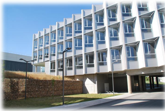
Figura 20. Disposición del acristalamiento para la correcta disposición lumínica del edificio LUCIA
