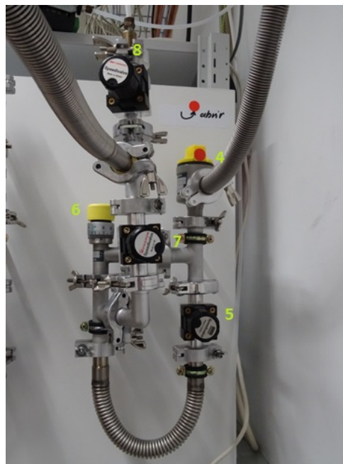
Figura A.2: Sistema de tuberías de vacío
