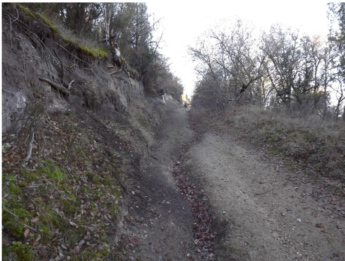
Figura 26: Pista de acceso a la ribera en el tramo 13 por la que se trazará la senda de interpretación.
