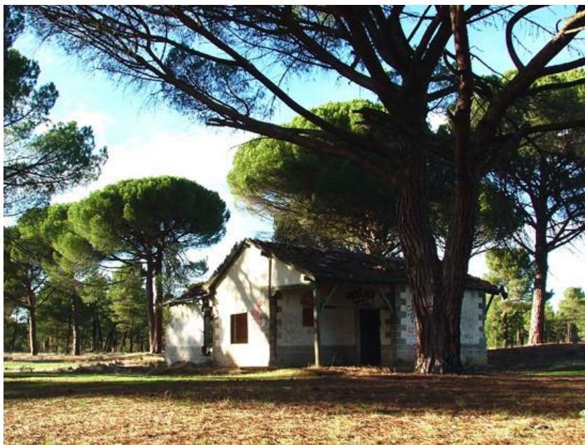
Figura 6: Casa de los alisos, situada en el final del tramo de estudio. (Tomado de: www.navadelaasuncion.org , 2016).
