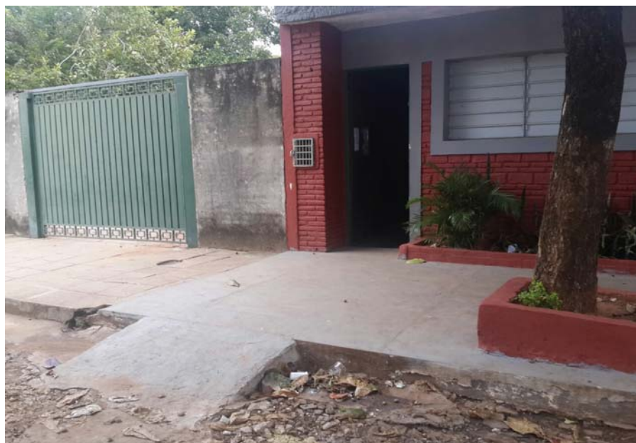
Rampa de acceso, ubicada en la acera frontal del edificio.
