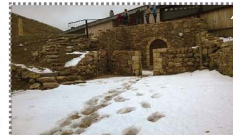
4 Reutilización de la bodega subterránea para almacenaje de material del nuevo taller textil.
