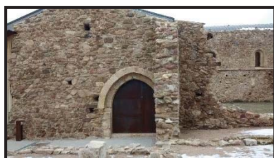
Img. 36_Acceso a la cilla
