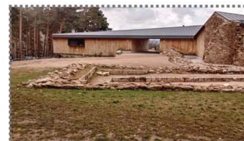
1 Desviación de la directriz del pabellón por la aparición de restos arqueológicos durante la construcción.
