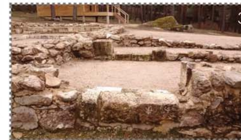
3 Añadidos puntuales de piezas de sillera y homogeneización del suelo con acabado uniforme.
