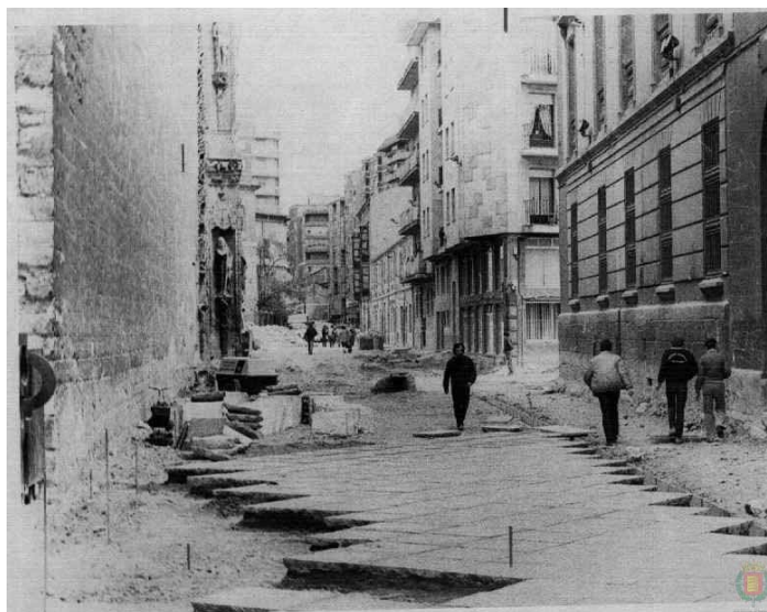
Pavimentación de la Calle Cadenas de San Gregorio
