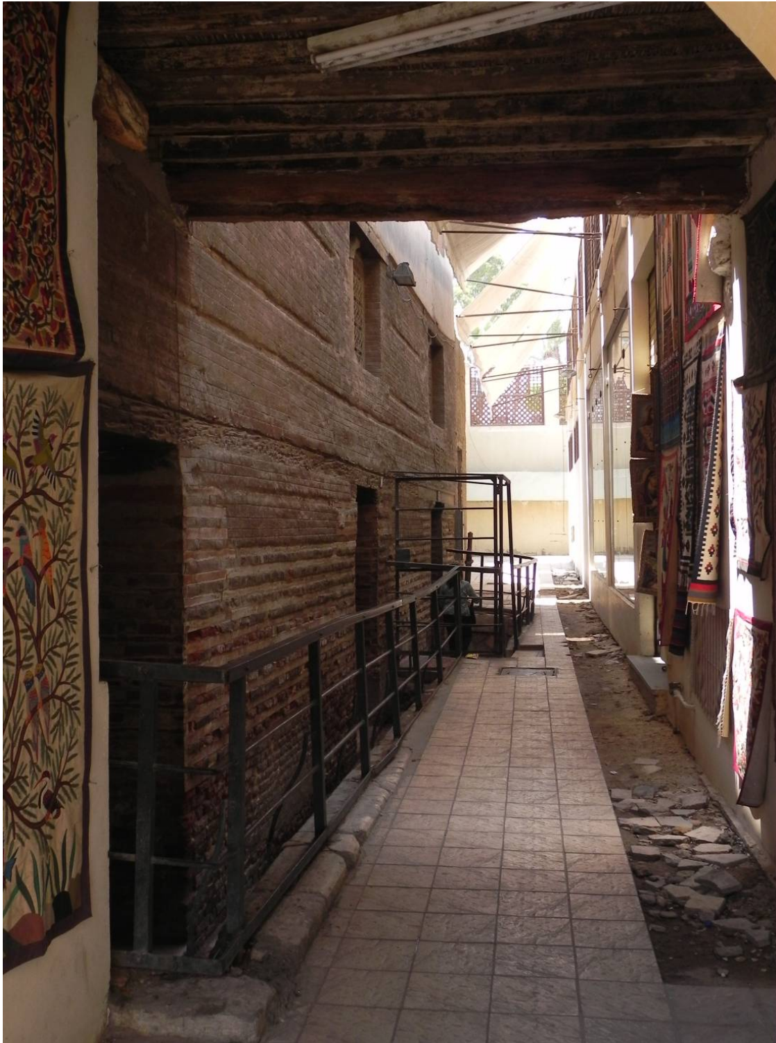
Fig. 85.- Fachada oeste de la iglesia de Abu Sirga antes de reabrirse el acceso central. Fotografía del doctorando.
