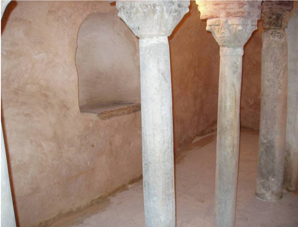
Fig. 319.- Estado de la cripta en mayo de 2005. En pocos meses las marcas de humedad eran evidentes debido a no dejar en los perímetros ningún espacio para facilitar la salida de la humedad. Fotografía del doctorando.
