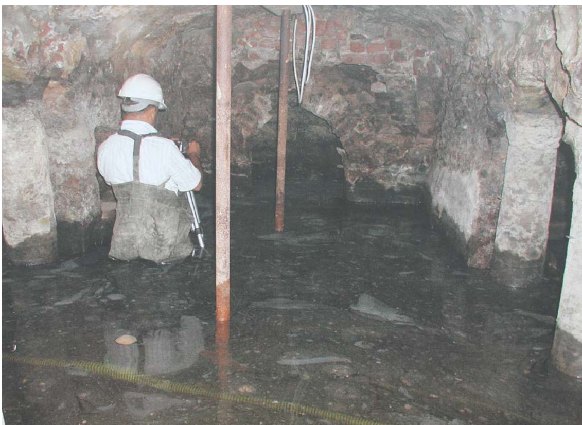
Fig. 73.- Rajan Patel, uno de los principales responsables de la empresa de ingeniería CCJM, encargada de dirigir el proyecto de USAID, toma imágenes en el interior de la cripta, inundada cuando dejaba de funcionar la bomba de achique. Fotografía de Peter Sheehan publicada como pl. 9 en Babylon of Egypt .
