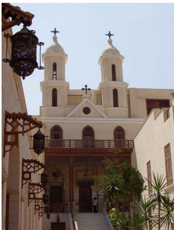
Fig. 199.- Fachada-campanario de la iglesia de al-Muallaqa. Fotografía del doctorando.
