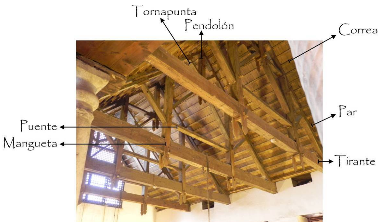
Fig. 138.- Detalle de la armadura de la cubierta. Fotografía del doctorando.
