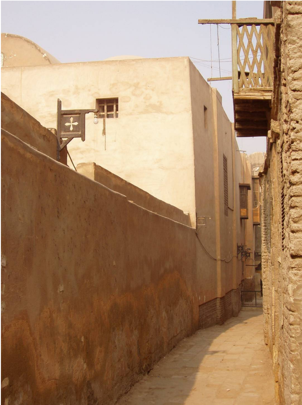
Fig. 84.- Esquina este de la iglesia de Abu Sirga desde el exterior. Fotografía del doctorando.
