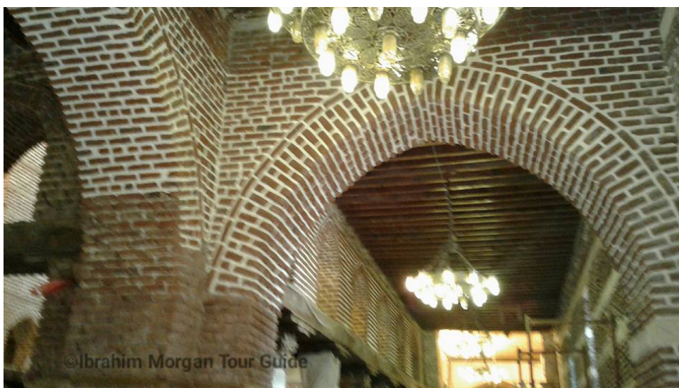
Fig. 341.- Trabajos realizados en noviembre de 2015 sobre los muros interiores de la iglesia de Abu Sirga. Imágenes obtenidas del Facebook de Ibrahim Morgan (20/3/2016).
