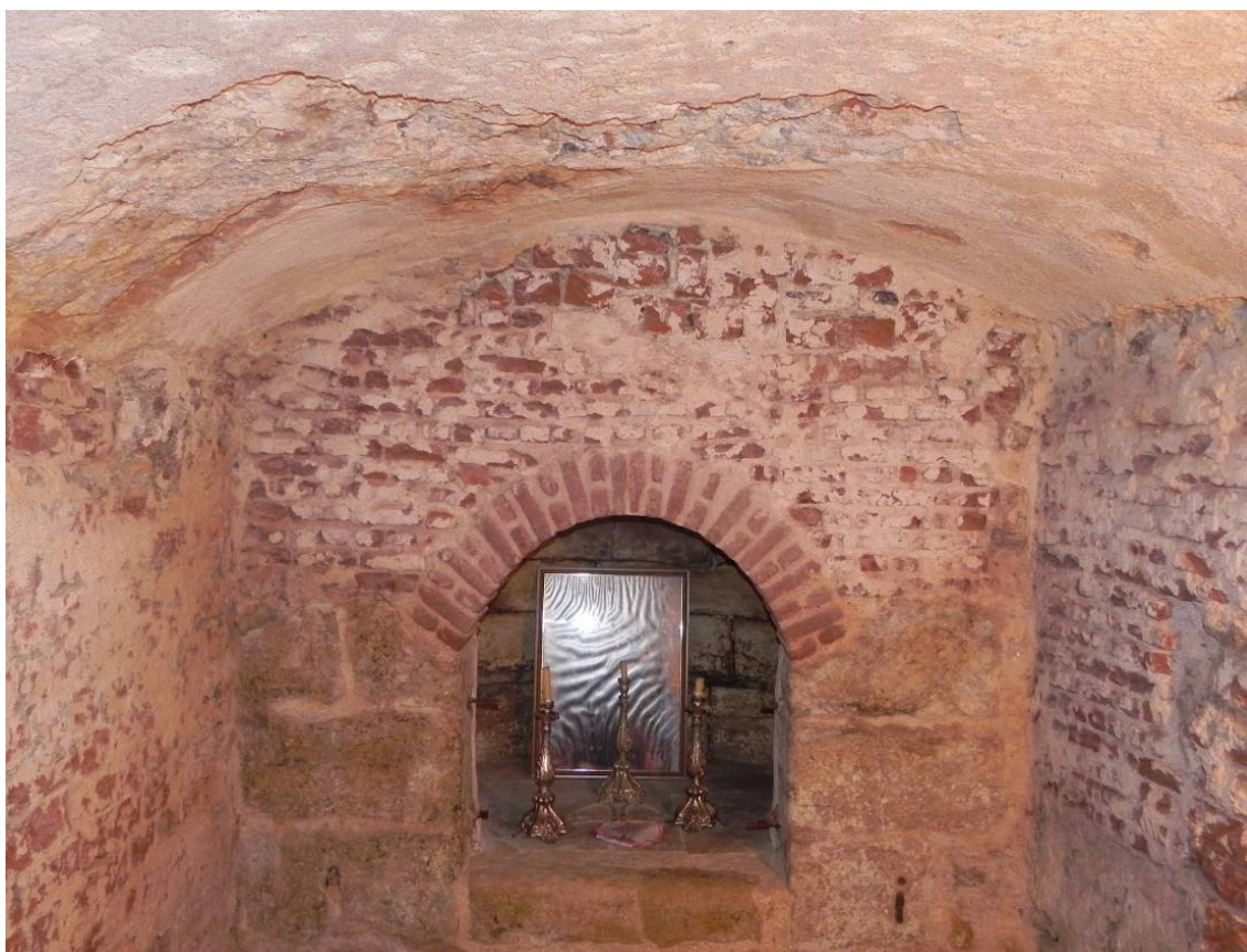
Fig. 65.- Estado del nicho del ábside central de la cripta en agosto de 2010, que destaca en el conjunto de la iglesia por el buen trabajo de sillería de piedra y mármol. Fotografía del doctorando.
