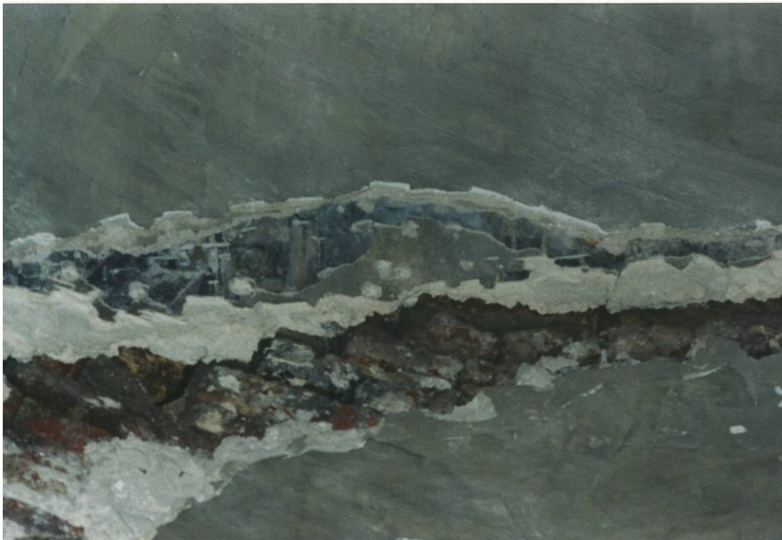
Fig. 267.- Primera cata en el remate del ábside derecho previa a descubrir los restos de pinturas murales. Fotografía del doctorando.
