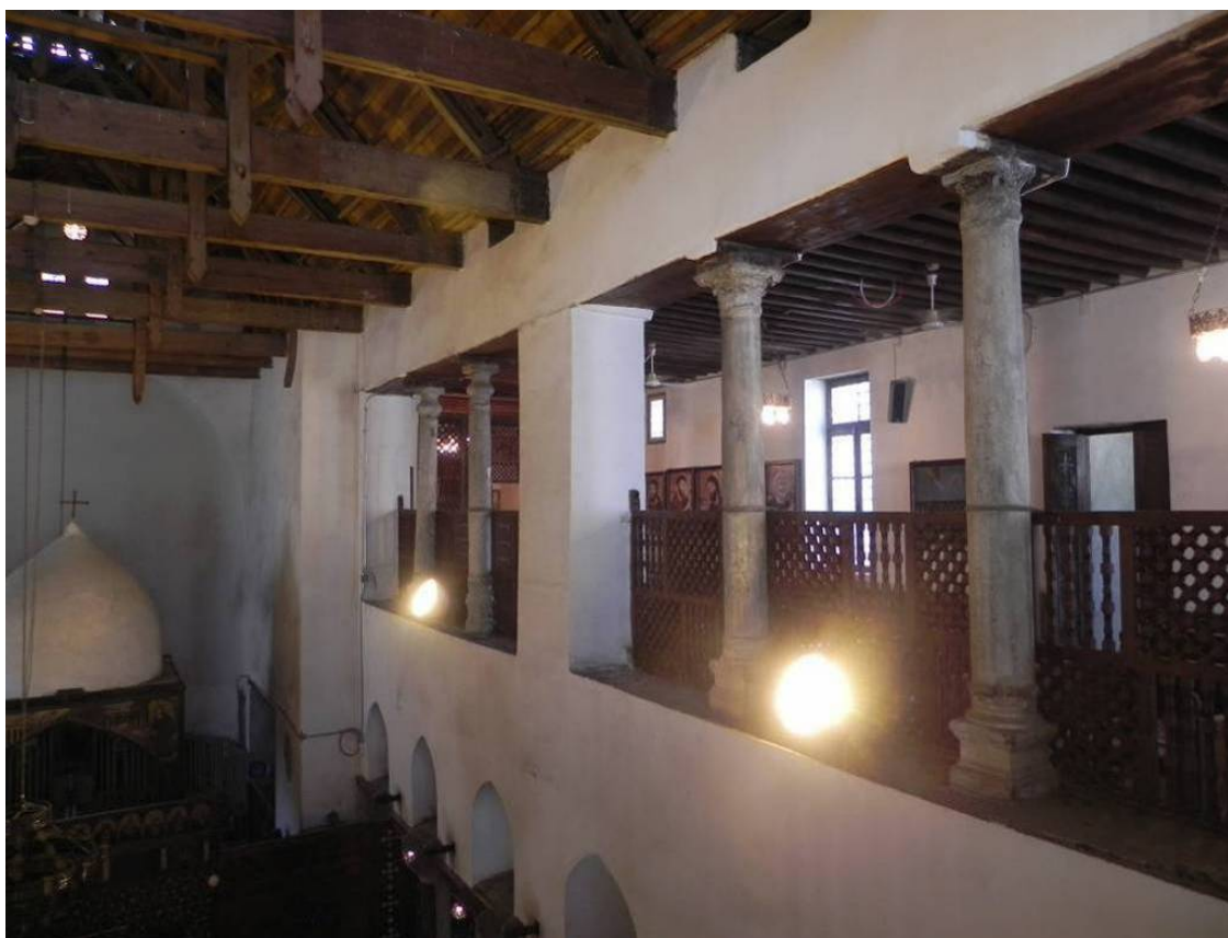
Fig. 111.- Tramo sur de la galería de la iglesia de Abu Sirga. Fotografía del doctorando.
