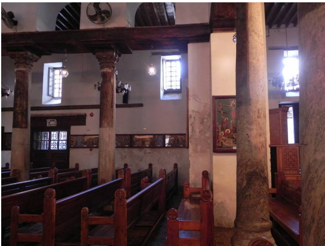
Fig. 212.- Pilares cruciformes a los pies de las líneas de columnas de separación de las naves en la iglesia de Abu Sirga. Fotografía del doctorando.
