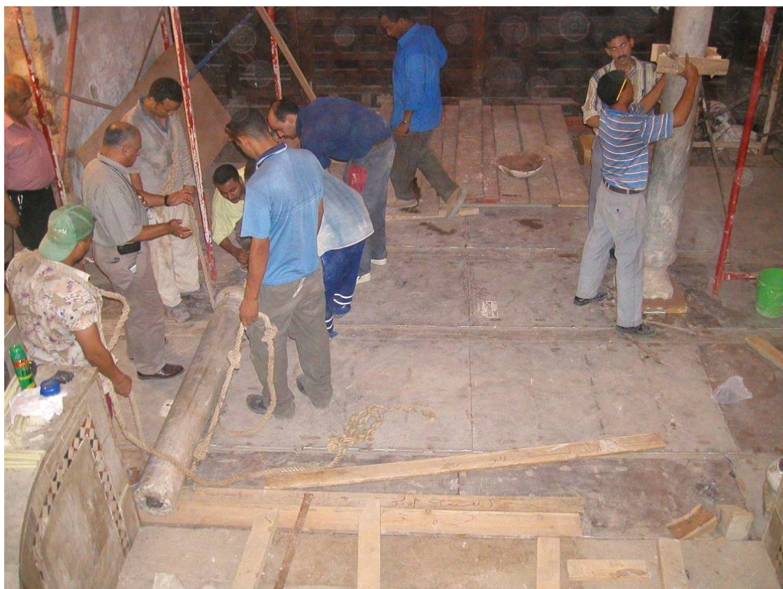
Fig. 328.- Recolocación de las columnas del baldaquino tras la excavación arqueológica y la colocación de una estructura metálica como suelo que evita cargas en el techo de la cripta. Fotografía de Alberto Guerrero.
