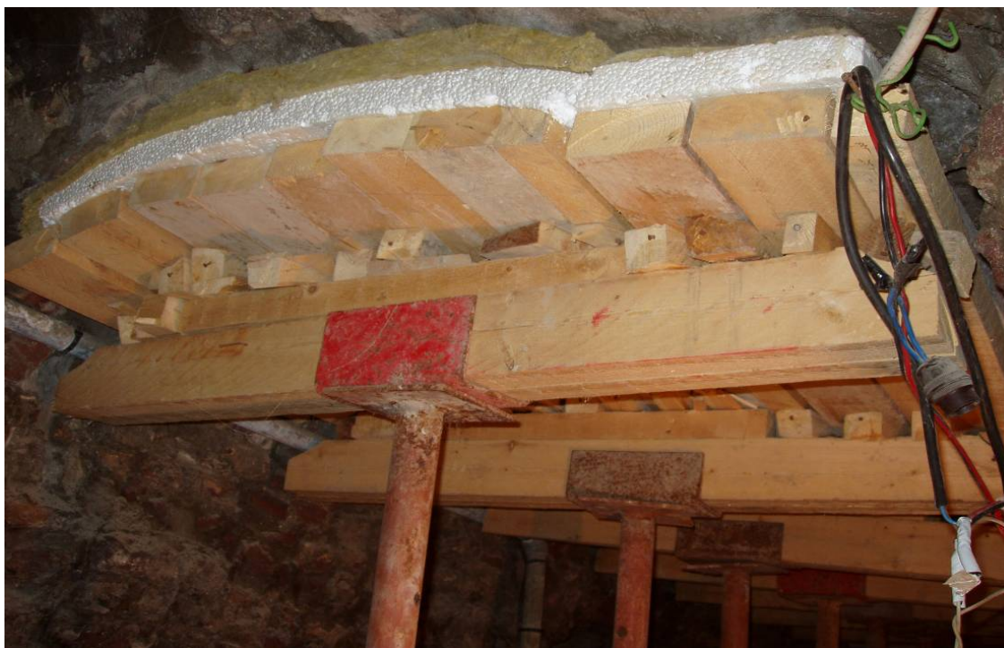
Fig. 332.- Detalle del apeo de la cripta como medida preventiva ante posibles daños derivados de los trabajos arqueológicos en el suelo del haykal . Fotografía del doctorando.
