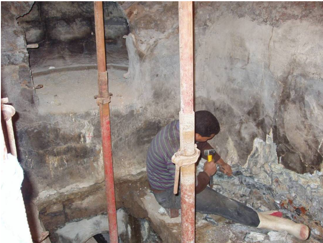
Fig. 286.- Eliminación de las capas de cemento hidrófugo de las paredes de la cripta de Abu Sirga. Fotografía del doctorando.
