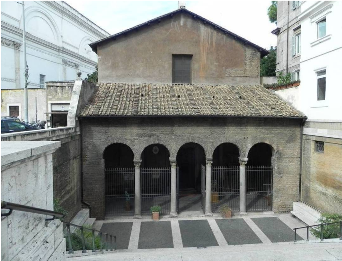
Fig 186.- Nártex de la iglesia de San Vital en Roma (Principios del siglo V). Fotografía del doctorando.
