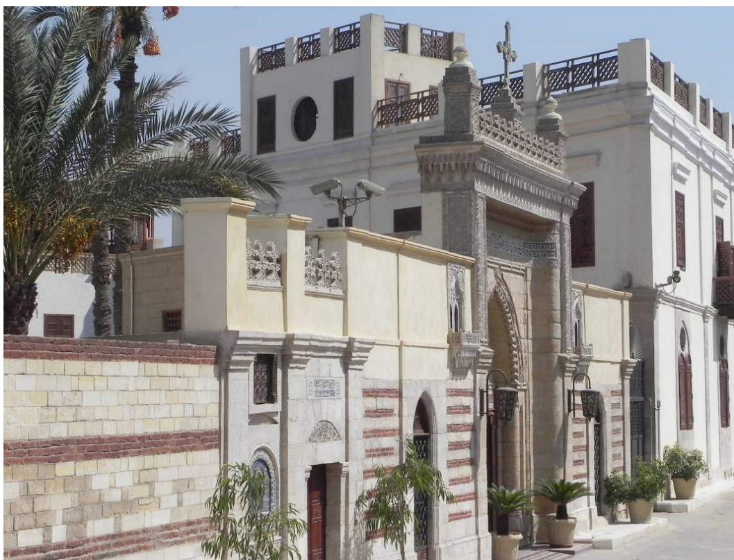
Fig. 198.- Arco exterior de acceso al recinto de la iglesia de al-Muallaqa (“la colgante”). Fotografía del doctorando.
