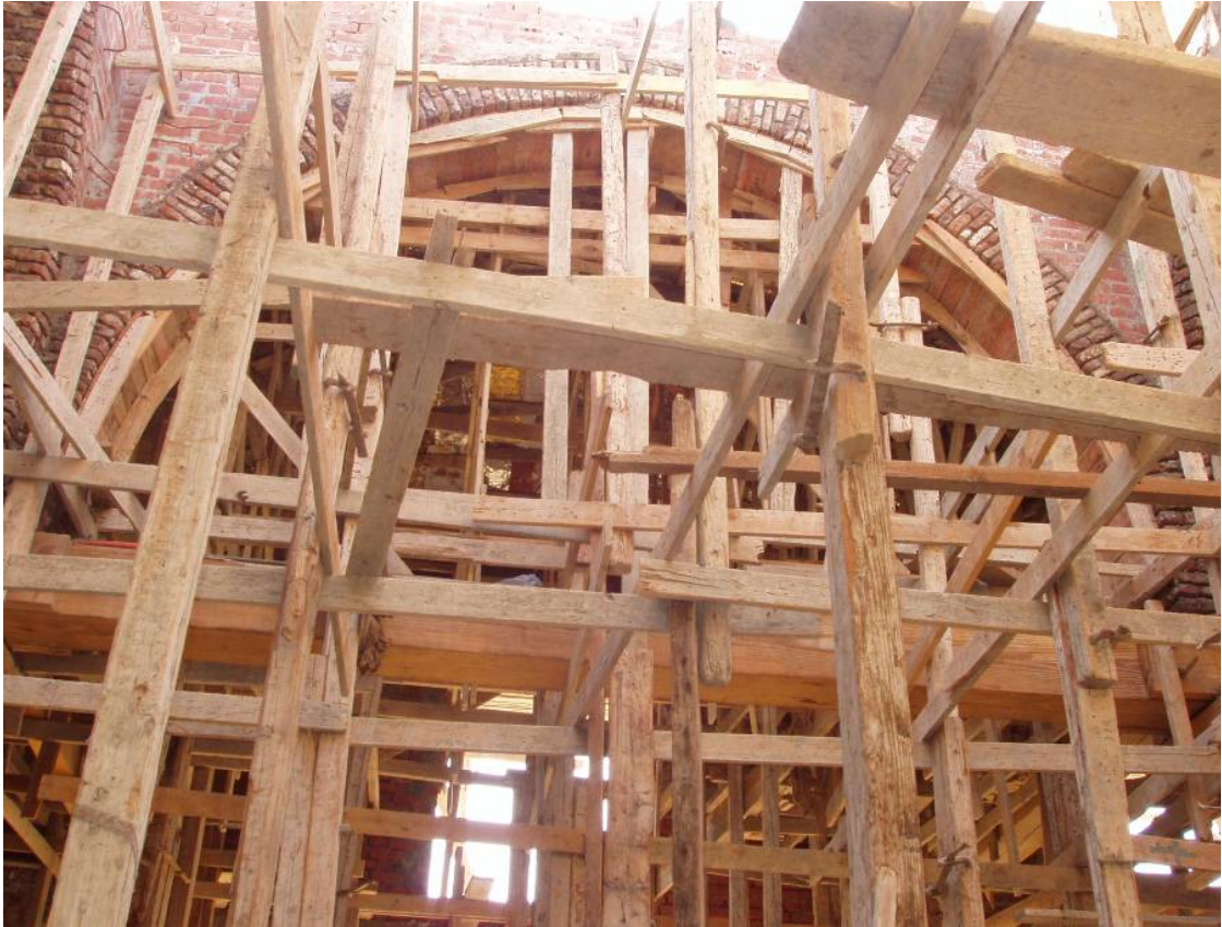
Fig. 204.- Andamios y cimbras de madera en una iglesia copta en construcción a principios del siglo XXI. Fotografía del doctorando.
