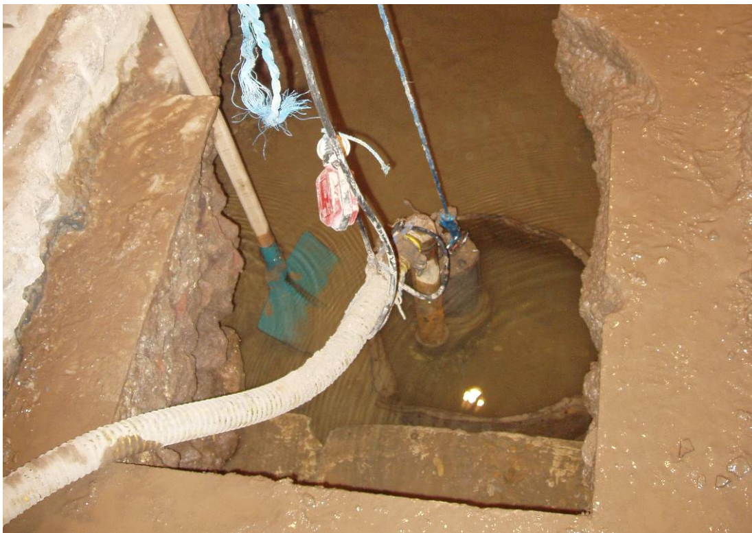
Fig. 292.- Sucesión de estratos en el entorno de la cabecera de la cripta: a la izquierda capa de hormigón vertida por Egy-Tech; bordeando el hueco, el suelo de mármol que puso el Comité ; bajo el agua, lo que parece un banzo sería el borde del muro del Canal de Trajano; y entre medias el suelo medieval. Fotografía del doctorando.
