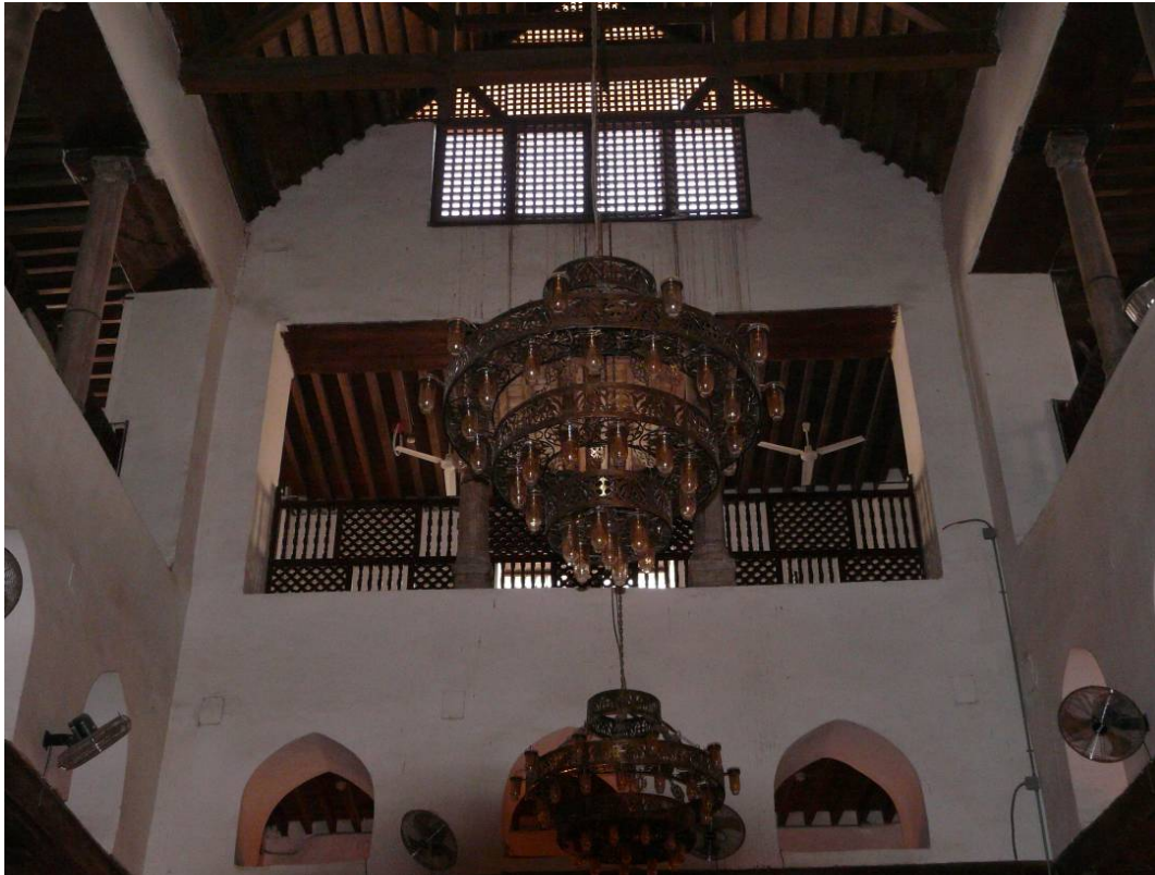
Fig. 114.- Parte superior del muro oeste de la iglesia de Abu Sirga desde el interior a la altura de las columnas. Fotografía de José Miguel Nieto.
