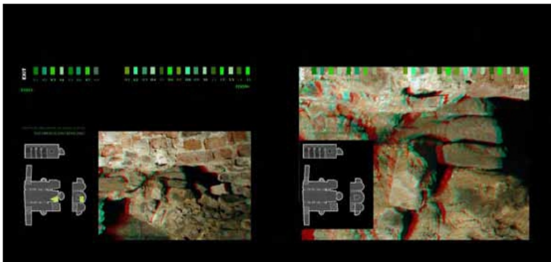
Pantallas con imágenes de detalle del estado de las fábricas
