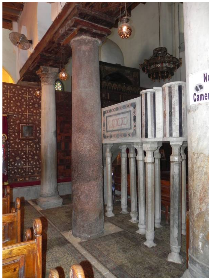
Fig. 151.- Columna de granito rojo sin capitel ni basa en el tramo izquierdo de la iglesia de Abu Sirga. Fotografía del doctorando.
