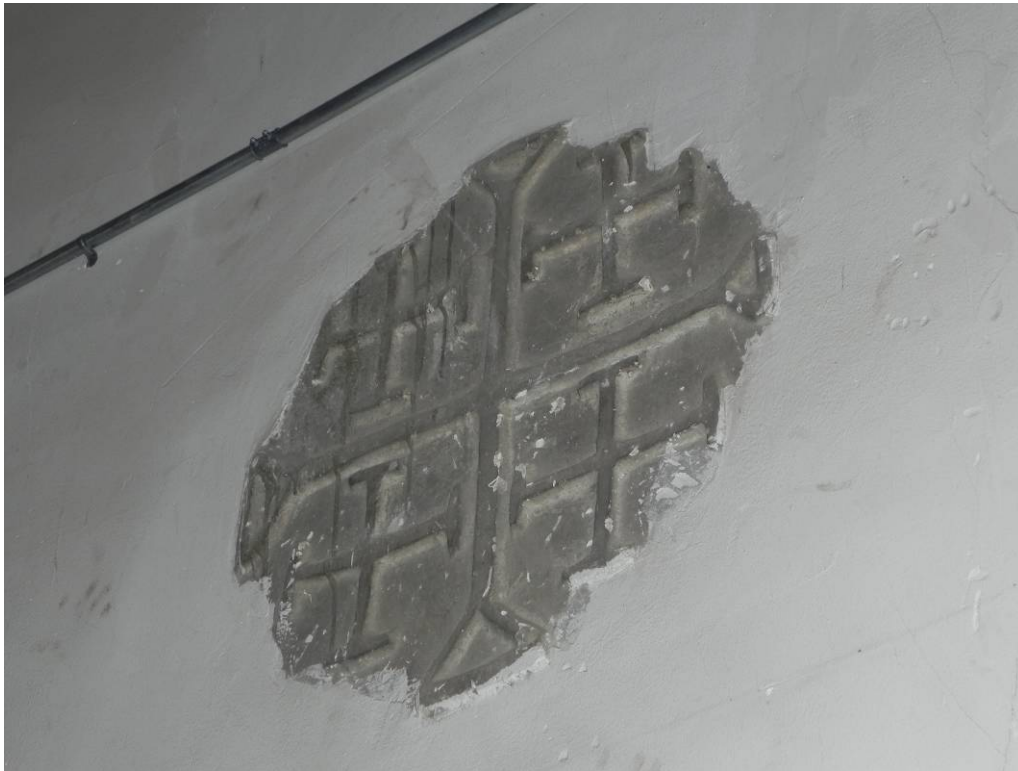
Fig. 107.- Cruz del Santo Sepulcro o de Jerusalén labrada en piedra en el muro sur del presbiterio de la iglesia de Abu Sirga, redescubierta durante los trabajos de restauración. Fotografía del doctorando.
