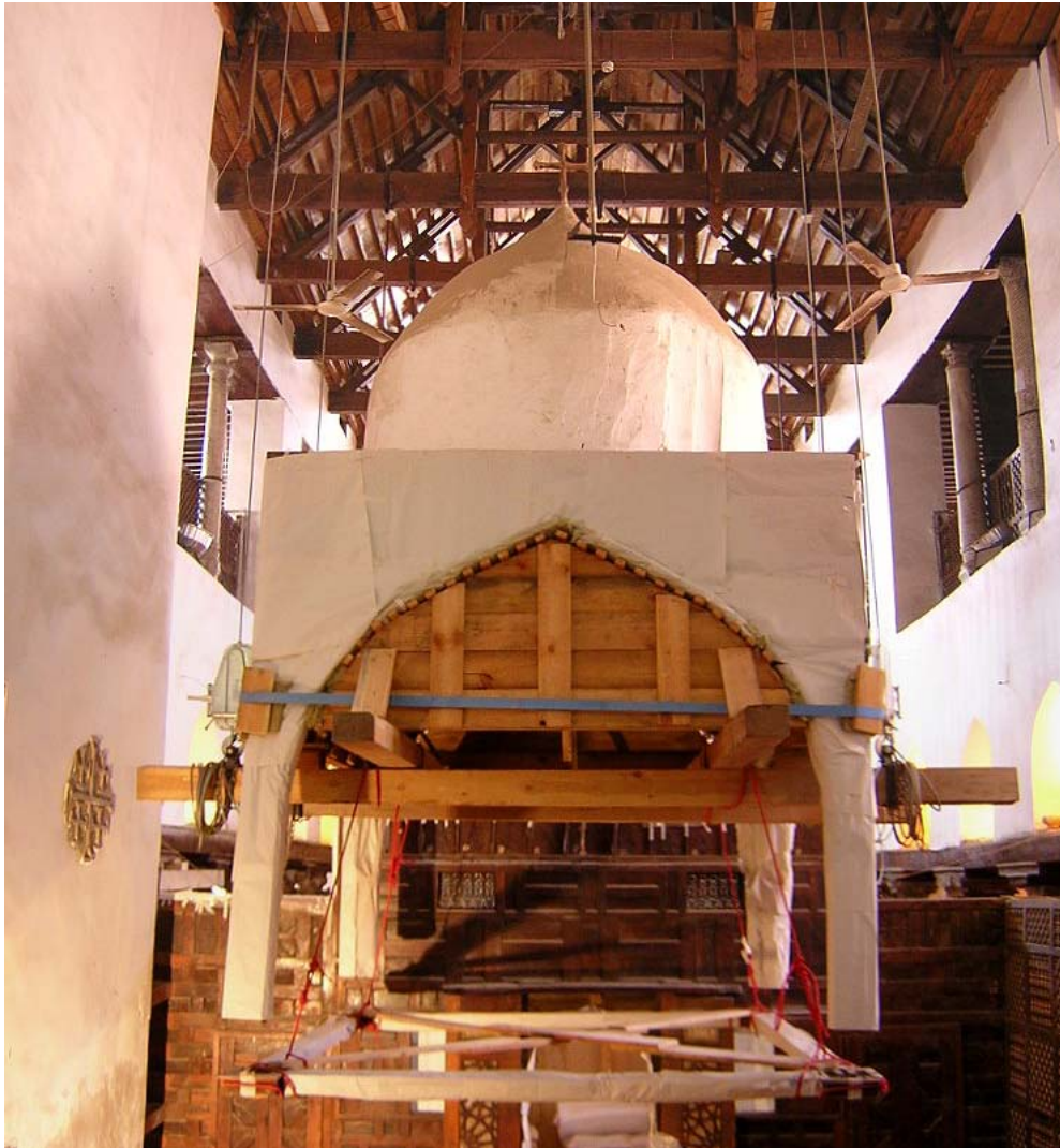
Fig. 325.- Baldaquino de la iglesia de Abu Sirga suspendido del techo. Fotografía de Jesús Arenas.
