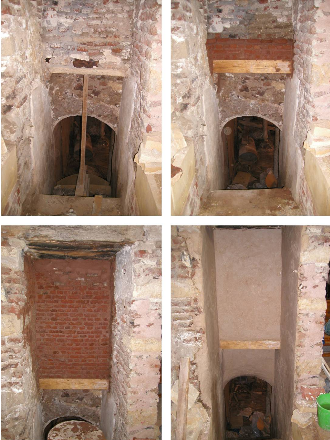
Fig. 266.- Progresión de los trabajos de consolidación del muro que hay sobre la escalera del muelle sur y del enfoscado final con cal y arena en el mismo. Fotografías del doctorando.
