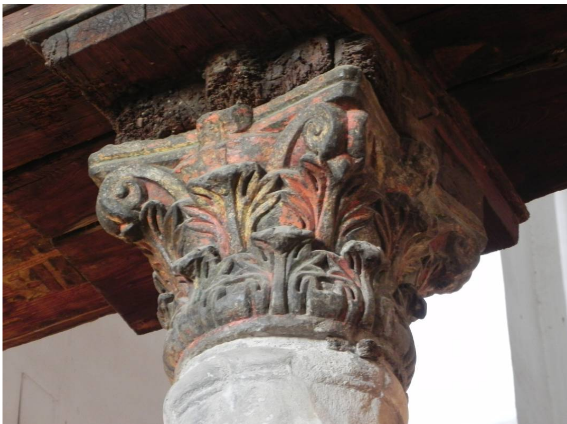
Fig. 148.- Detalle de uno de los capiteles corintios del piso bajo de la iglesia de Abu Sirga, en el que resulta evidente tanto el menor tamaño en relación al fuste, como la desconexión con respecto al dintel de madera. Fotografía del doctorando.
