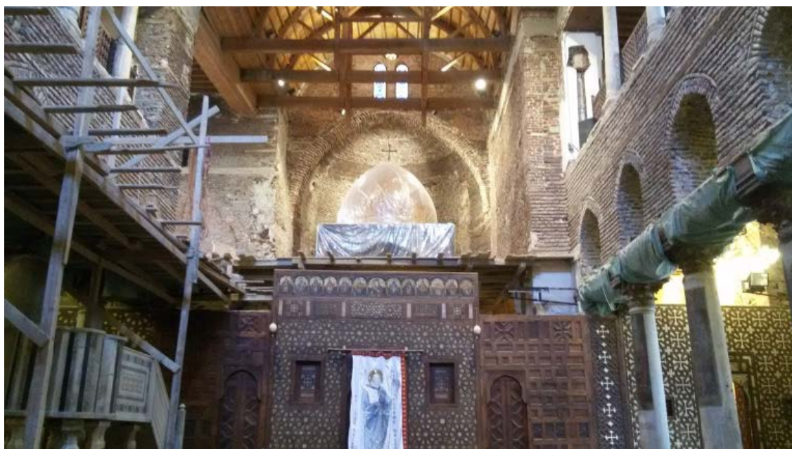
Fig. 265.- Interior de la iglesia de Abu Sirga tras eliminar el recubrimiento de los muros. Fotografía de Joe AZ obtenida de Google (15/12/2015).
