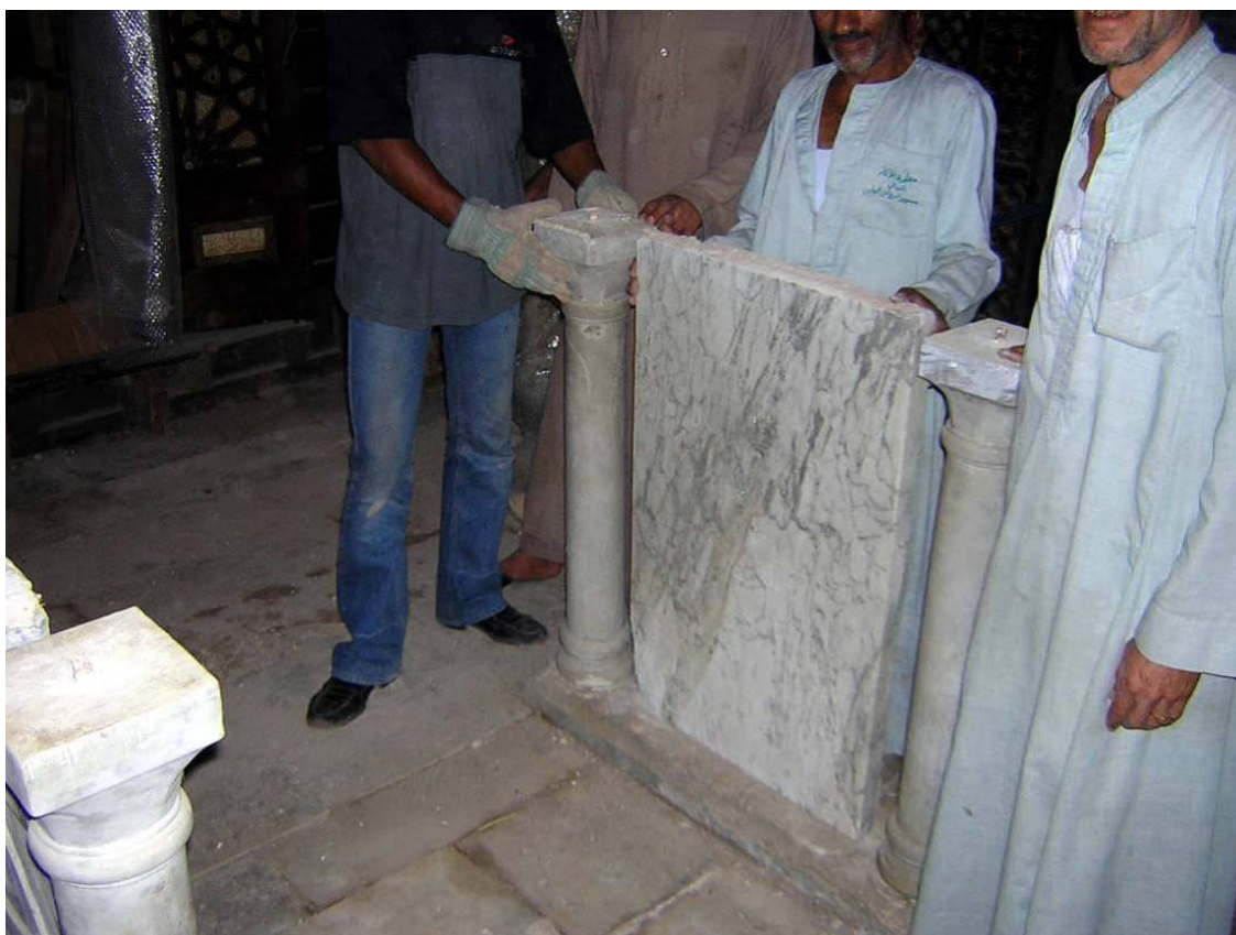
Fig. 272.- Desmontaje del altar colocado durante la restauración llevada a cabo por el Comité a principios del siglo XX antes de la excavación del suelo del haykal . Fotografía del doctorando.
