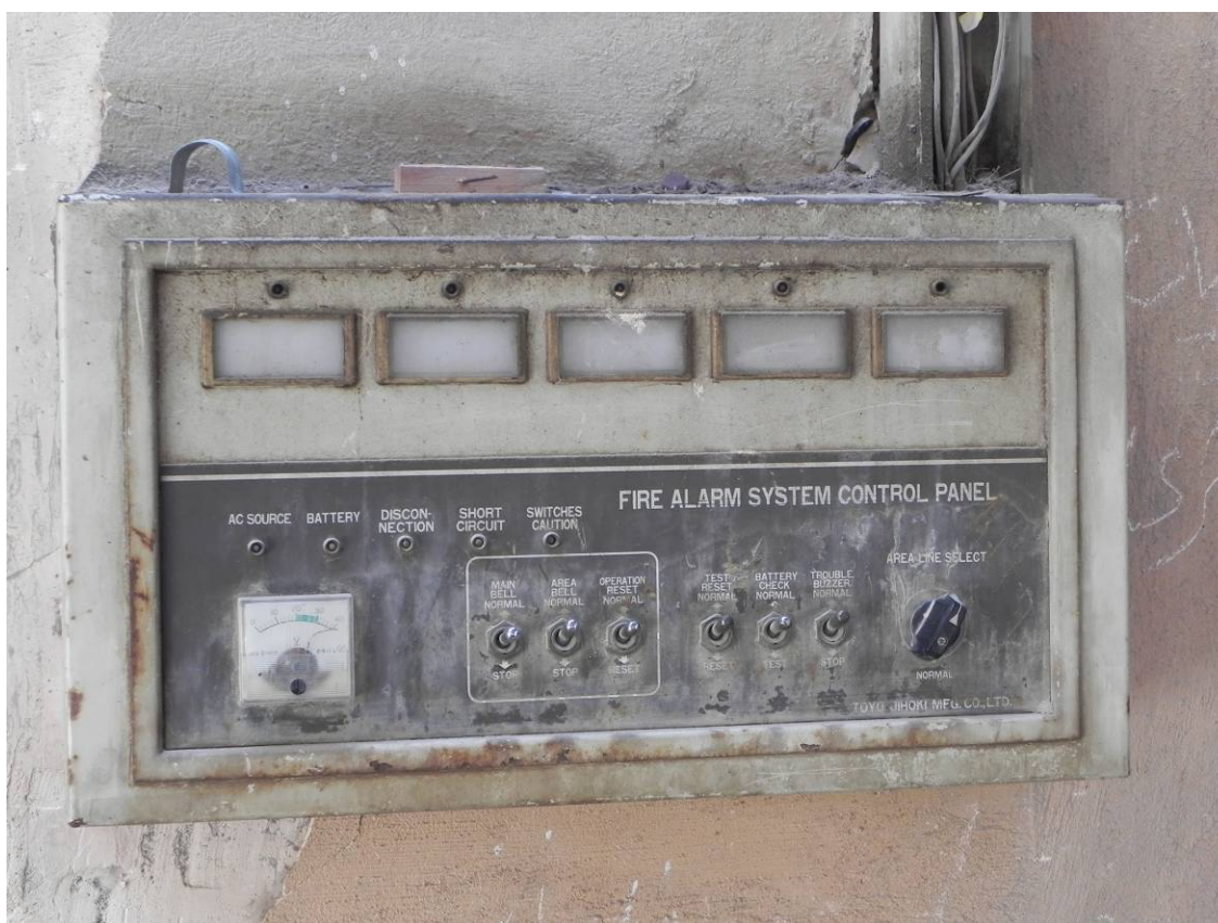
Fig. 323.- Panel de control del sistema anti-incendio de la iglesia de San Sergio. Fotografía del doctorando.
