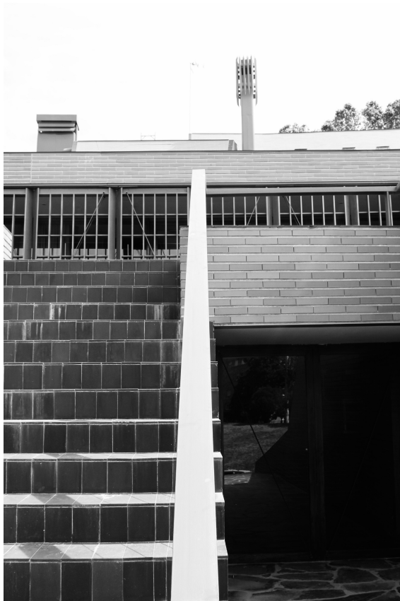
4.22 Foto de CMNSL .Vista de escaleras hacia la terraza.
