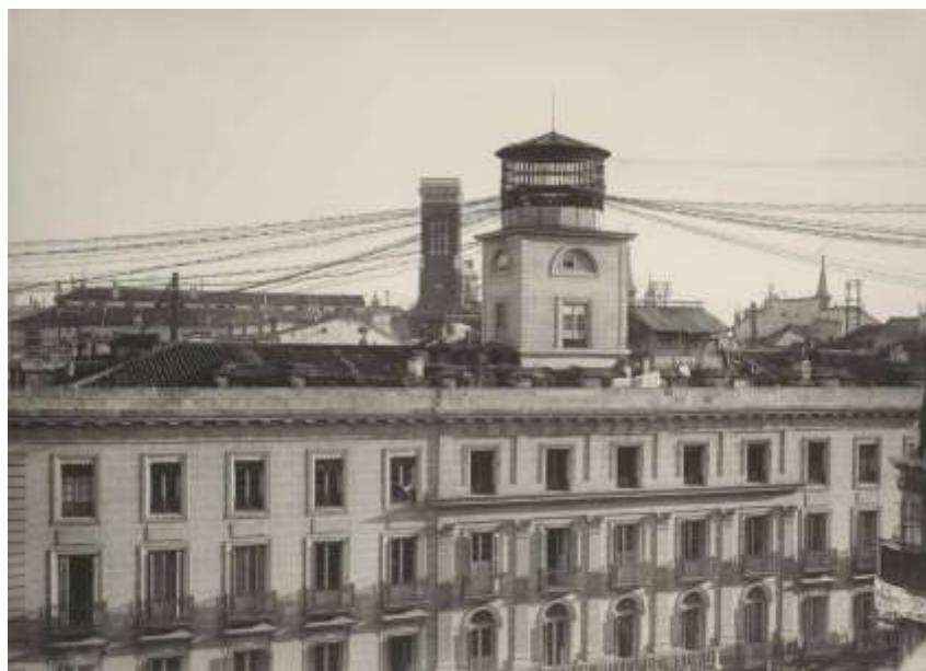
(115) Templete de la Central Urbana de Madrid de servicio público 37 .
