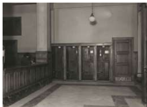
(240) Sala del público en la planta baja de la Central 39 .
