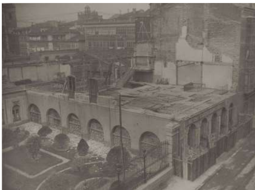
(236) Derribo de la casa situada en la C/ Duque de la Victoria, nº 12 25 .
