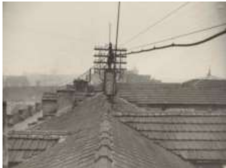
(137) Detalle de un soporte fijado en un tejado 64 .
