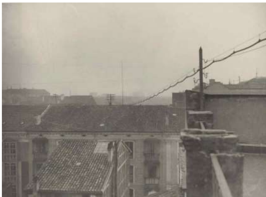
(124) Detalle de la red aérea de Valladolid con un poste con aisladores 23 .
