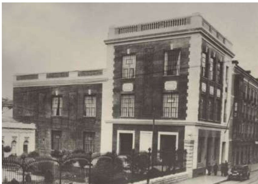
(239) Vista exterior de la Central Automática vallisoletana en 1929 38 .
