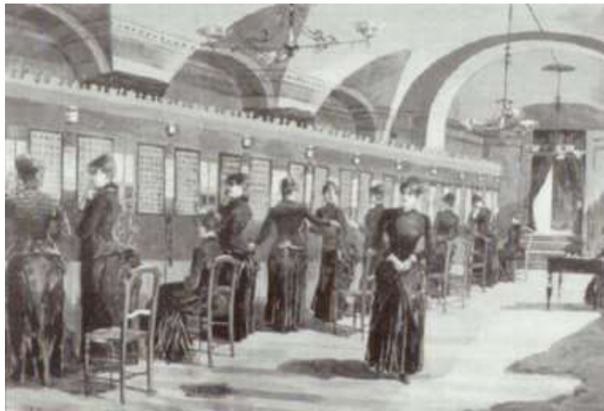
(116) Central de Teléfonos de Madrid atendida por mujeres en 1886 39 .
