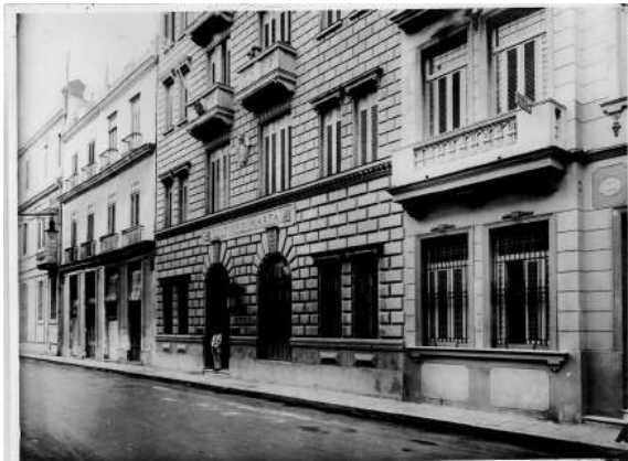
(212) Pequeños cables y cajas dispuestos sobre las fachadas de una serie de edificios en Valladolid 9 .
