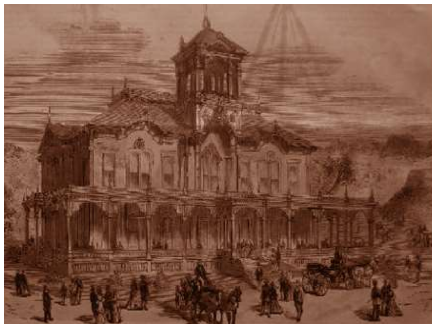
(39) Vista del edificio que albergaba la Exposición de Filadelfia 35 .
