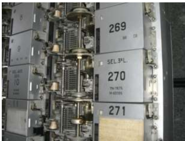
(261) Selectores auxiliares y terceros Rotary 115 .
