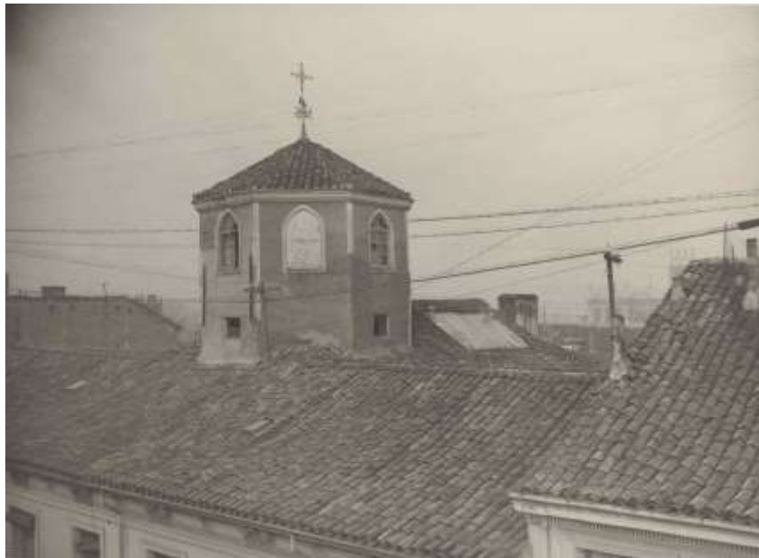
(135) Detalle de la red aérea de Valladolid con varios hilos y cables por los tejados 62 .
