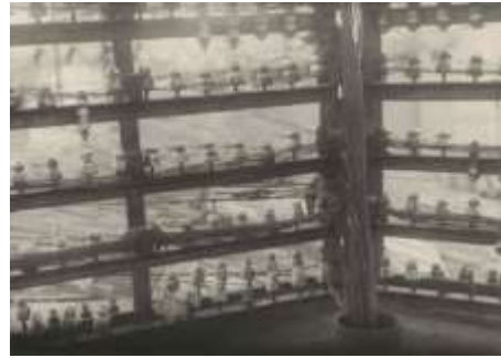
(134) Detalle de la torre con aisladores y cables 61 .
