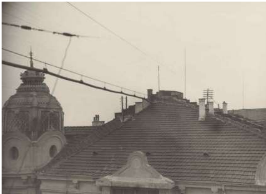
(125) Detalle de la red aérea de Valladolid con un cable tendido entre dos tejados 30 .
