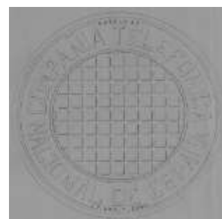
(221) Tapa exterior de una cámara de registro 24 .
