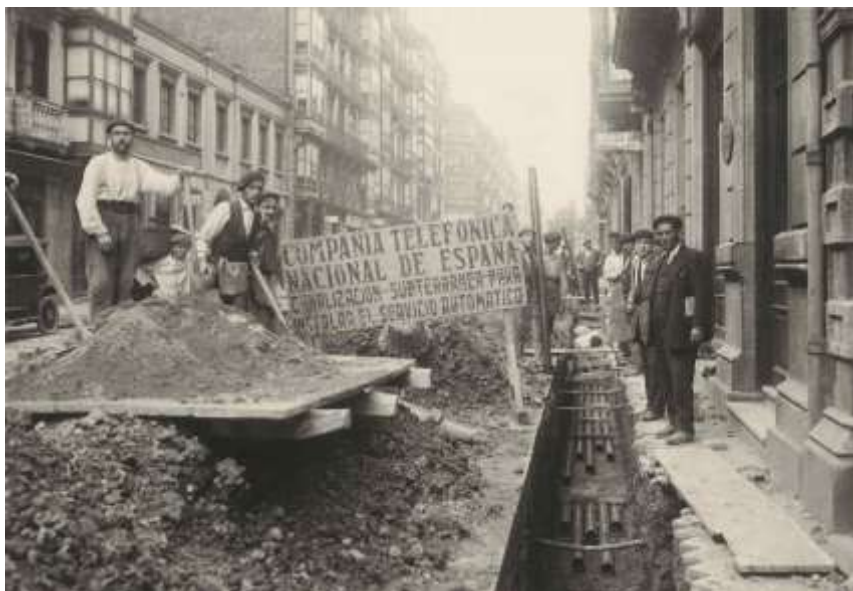
(201) Canalización subterránea de la red urbana de Madrid a finales de 1924 19 .
