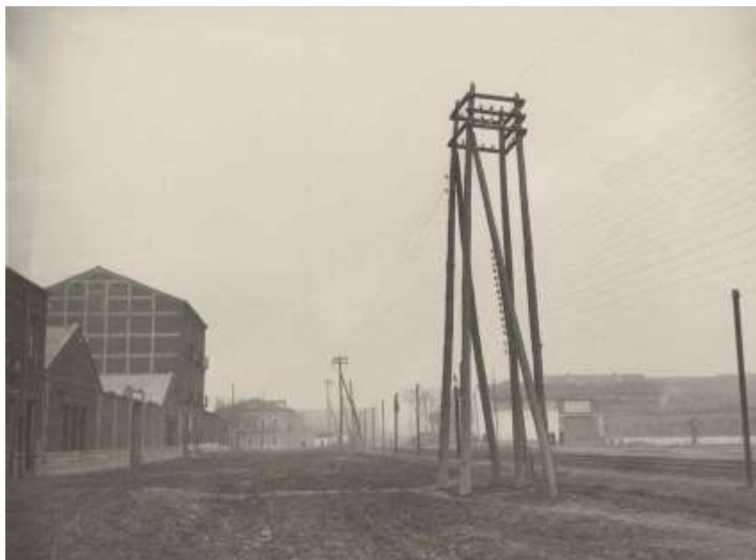
(138) Detalle de la red aérea de Valladolid con varios postes en el suelo 65 .
