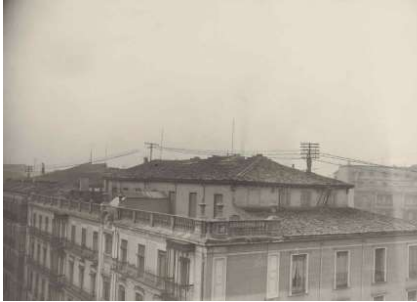
(136) Detalle de la red aérea de Valladolid con varios soportes en los tejados 63 .
