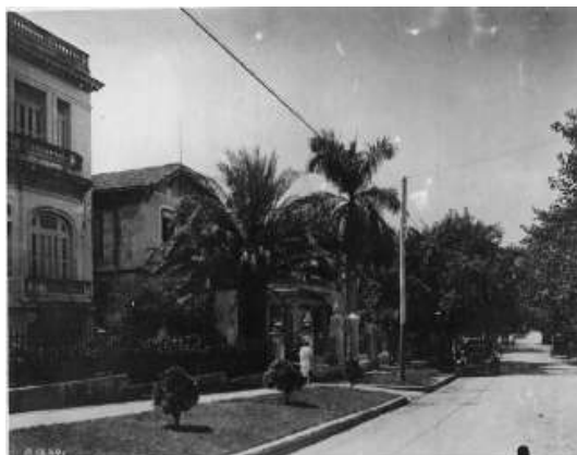
(213) Cable telefónico apoyado sobre postes a lo largo de una hilera de chalets en Valladolid 10 .
