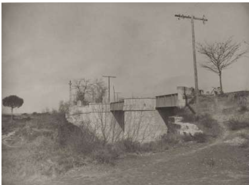
(208) Línea Madrid-La Coruña atravesando un puente a la altura de Boecillo 45 .
