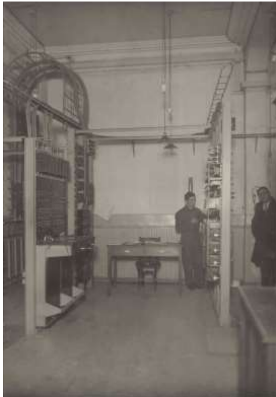
(246) Mecánico de la Compañía ajustando y limpiando relés 60 .
