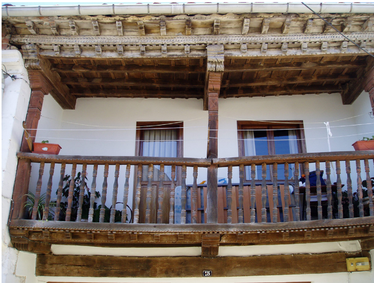
Cobijón (Santander). Vivienda con la característica solana en planta alta, construida con un complejo conjunto de elementos y piezas de madera. La solana es un elemento funcional y estético que homogeniza y da un carácter unitario a la arquitectura del lugar
