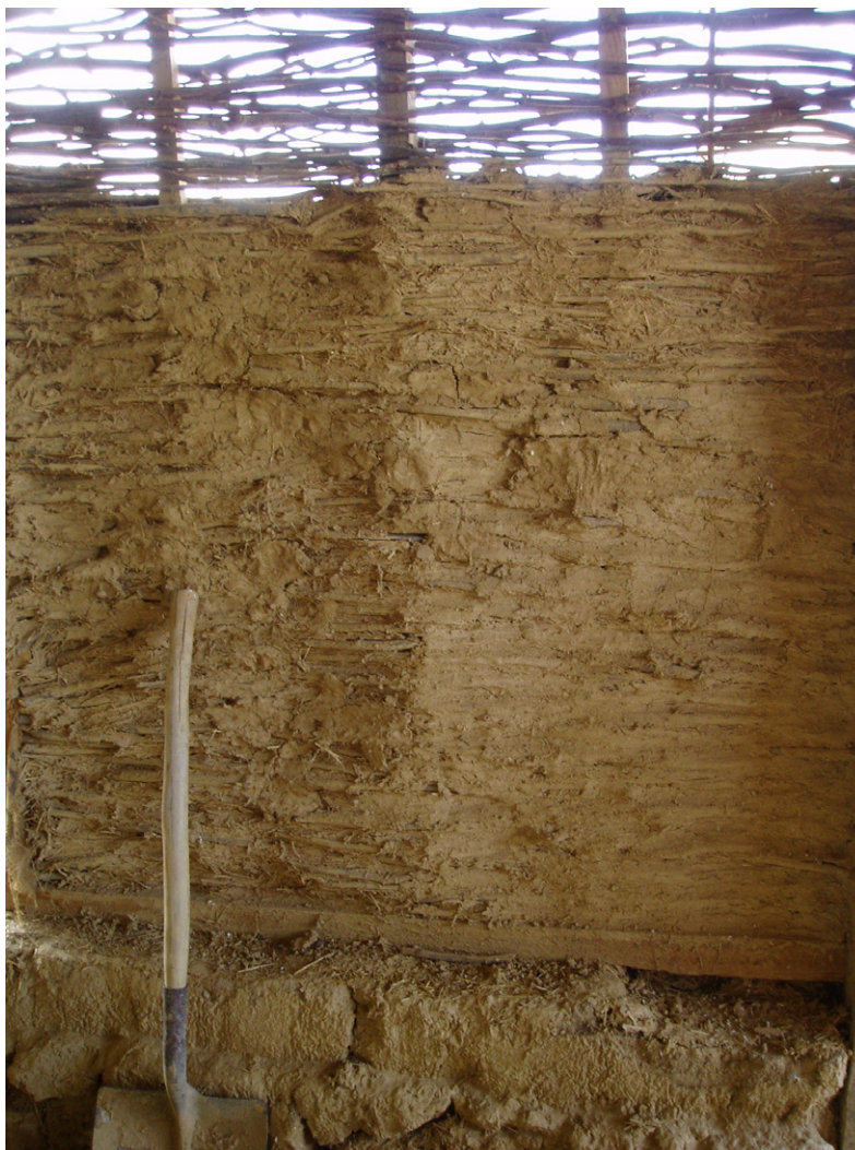
Amayuelas de Abajo (Palencia). Taller práctico para la recuperación de las técnicas tradicionales de construcción con tierra. Encestado y barreado; el encestado se ejecuta mediante elementos vegetales entrelazados y sujetos a una subestructura vertical
