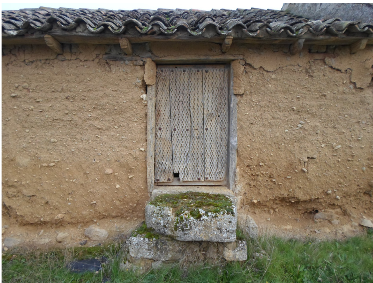
Amusco (Palencia). Descargadero de lagar construido con muros de tapia de tierra vertida. El hueco del descargadero está conformado mediante un simple cerco de madera y la puerta ejecutada mediante un viejo trillo reutilizado. Una gran piedra conforma el sitio para el apoyo de los cestos de mimbre, cargados de racimos de uva, para su vertido al lagar
