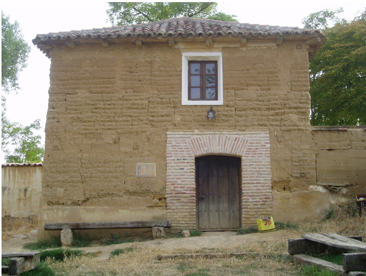
Amayuelas de Abajo (Palencia). Edificio construido con muros de tapia. La puerta de entrada aparece reforzada con fábrica de ladrillo y la ventana superior recercada y encalada de blanco para potenciar la entrada de luz al interior de la vivienda
