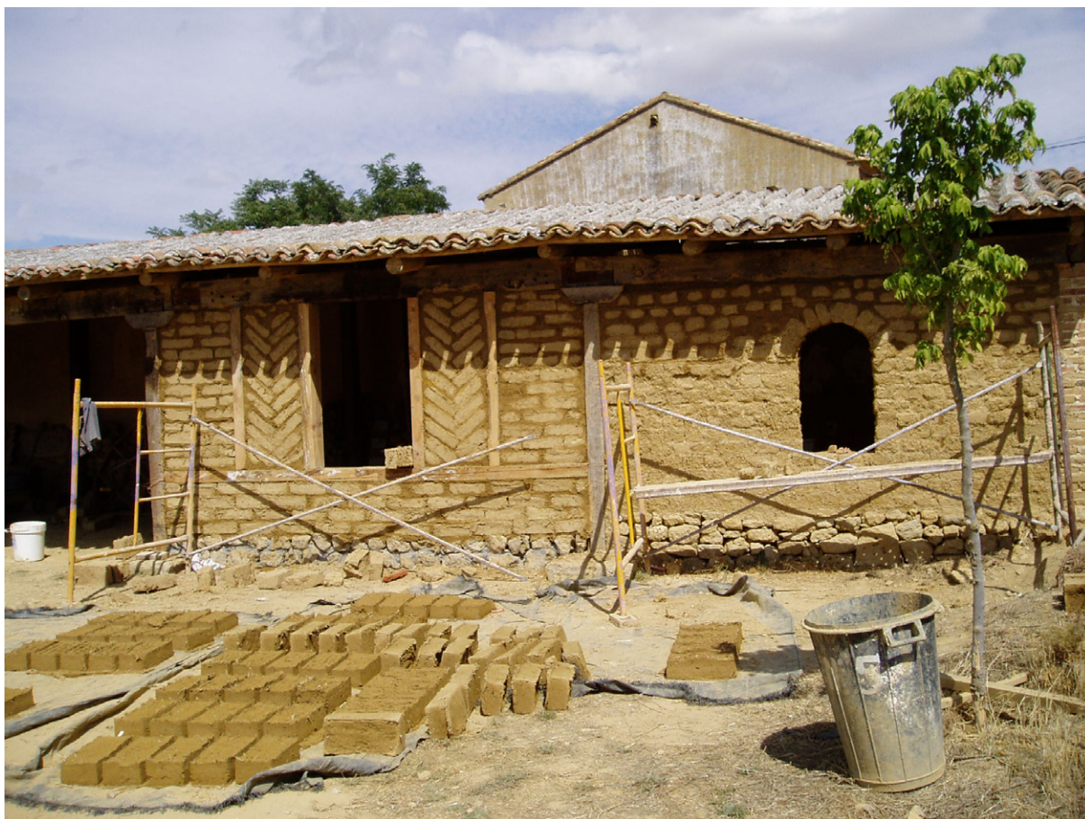
Amayuelas de Abajo (Palencia). Taller práctico para la recuperación de las técnicas tradicionales de construcción con tierra, Cátedra Juan de Villanueva (UVa). En primer término fabricación artesanal de adobes. Al fondo, construcción de diferentes tipos de muros; muro entramado con aparejo a espina de pez, muro aparejado, dintel curvo
