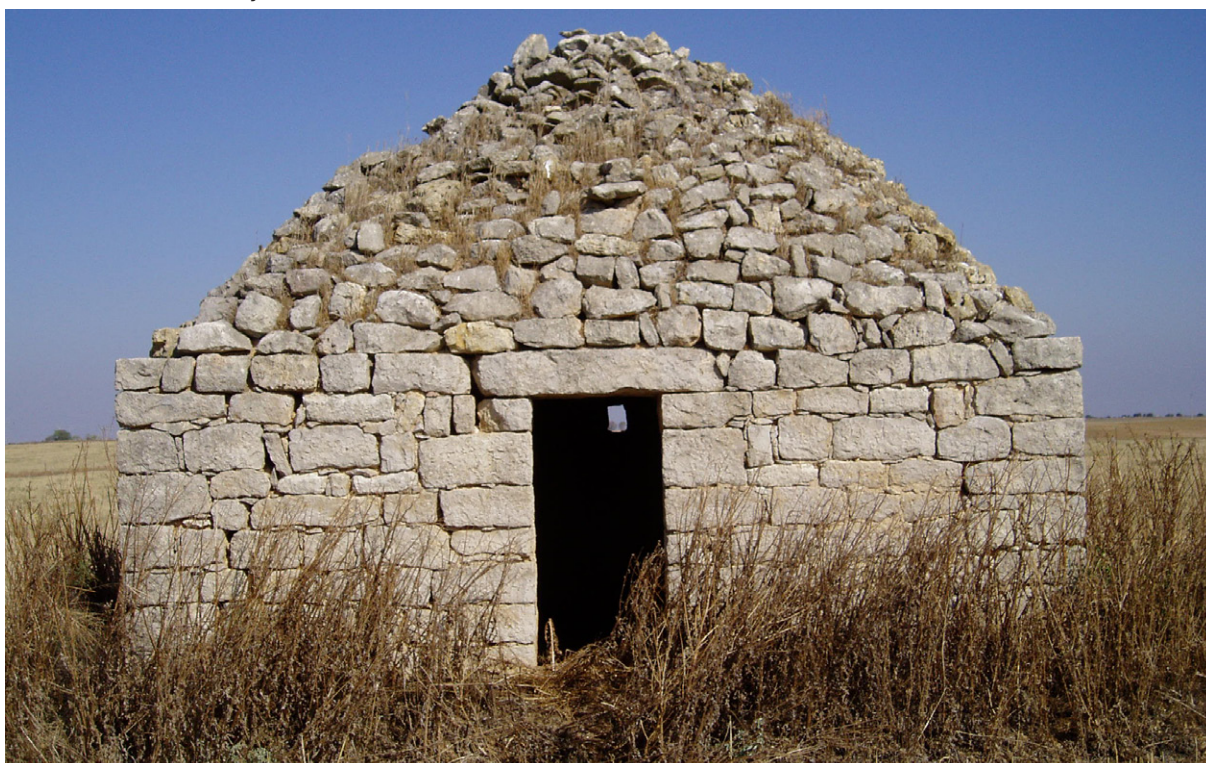
La Mudarra (Valladolid). Chozo de pastor construido con muros de sillarejo de piedra, sillares en las esquinas y el dintel de la puerta, y falsa cúpula de mampuestos para revestir con barro. Constituye un ejemplo muy culto de arquitectura tradicional asociada a una construcción secundaria vinculada a la producción agraria y ganadera
