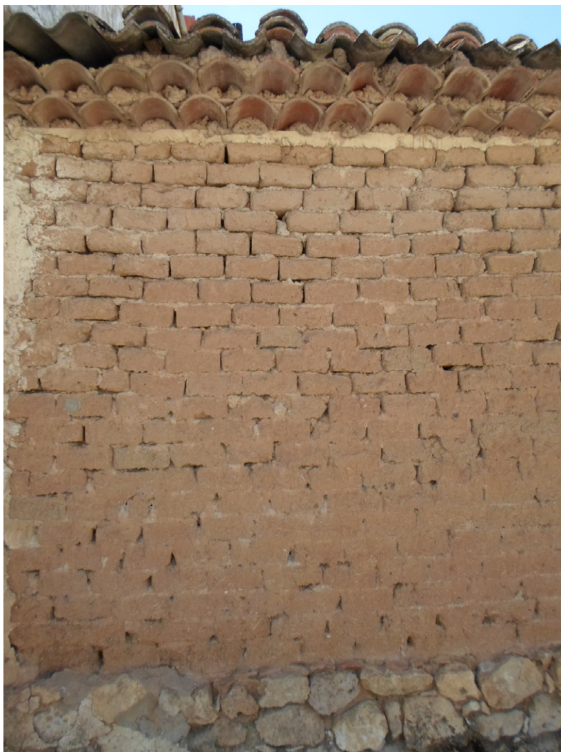
Cuenca de Campos (Valladolid). Edificio construido con muro de adobe con alero de triple teja volada. El adobe se apareja a tizones recibido con mortero de barro y nace sobre un cimiento sobreelevado de mampostería de piedra
