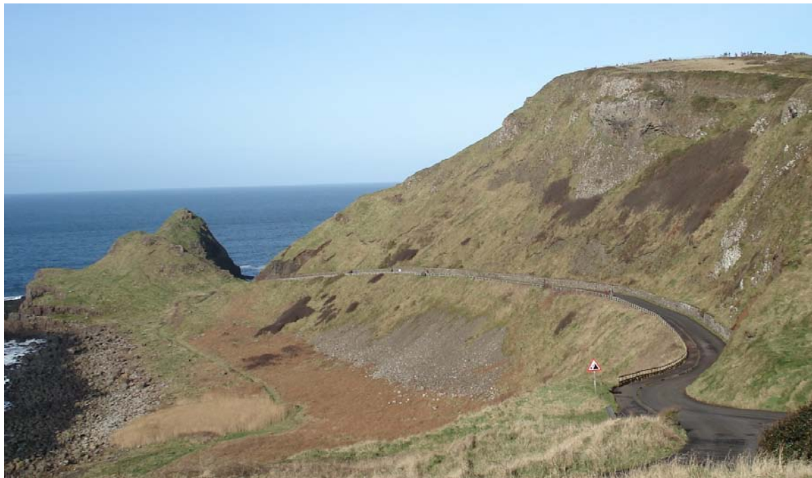
Figura 11.4: Vista de la carretera que comunica la Calzada del Gigante con lo alto del acantilado. La carretera discurre a través de deslizamientos parcialmente estabilizados y bajo paredes rocosas con desprendimientos ocasionales (como denota la señal y el muro de protección). Una mayor frecuencia de estos procesos conllevaría su cierre (además de un aumento de la geodiversidad).
