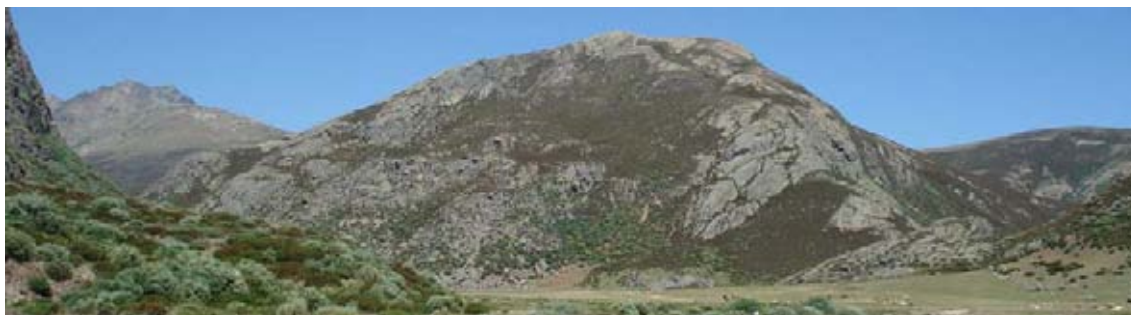
Figura 7.30: Vista hacia el W del deslizamiento de Coto Redondo desde el Estrecho.
