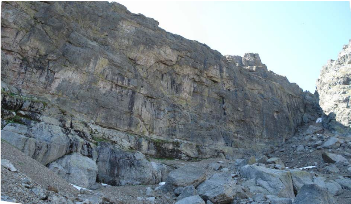
Figura 7.28: Cicatriz del desprendimiento en la cara N del Curavacas.
