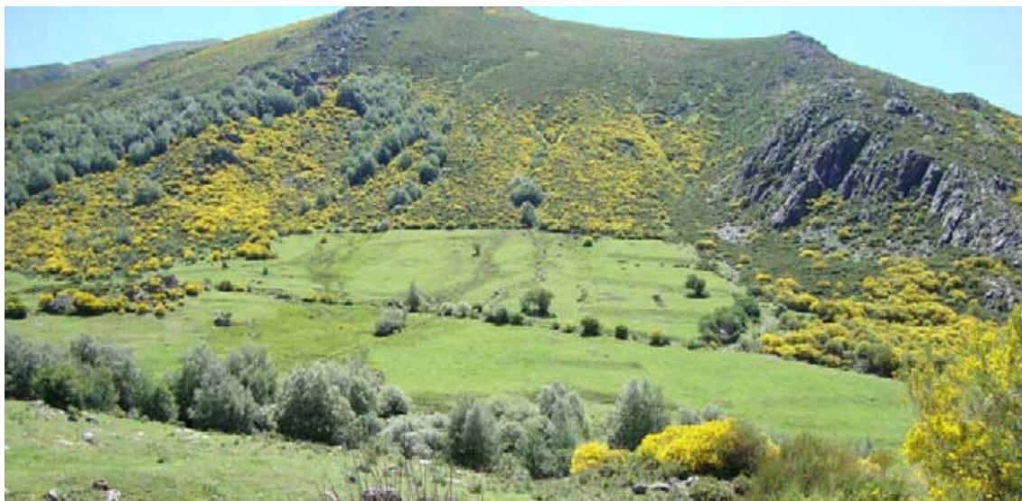
Figura 7.13: Vista desde el NW del deslizamiento traslacional de Cardaño de Arriba.
